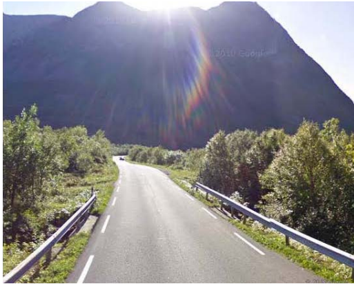
Figur 62. Kulvert ved elv fra Olvikvatnet.
