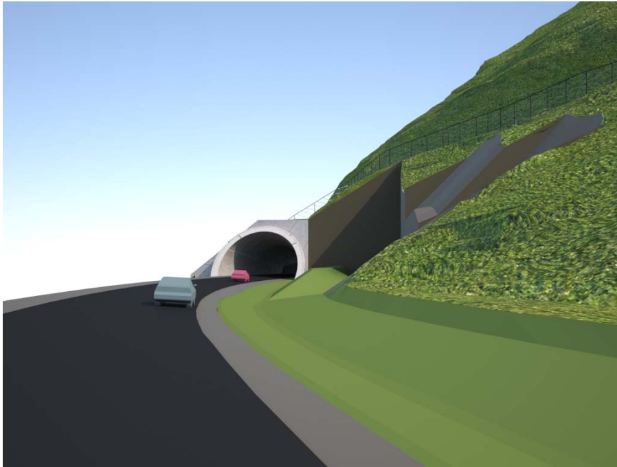
Figur 31. Illustrasjon av portalområde og rassikring sett fra vegen.
