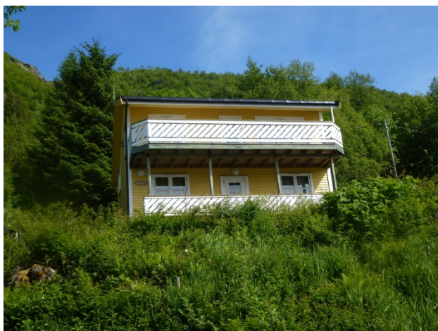
Figur 46. Hus/fritidshus ved profil 230 foreslås innløst.
