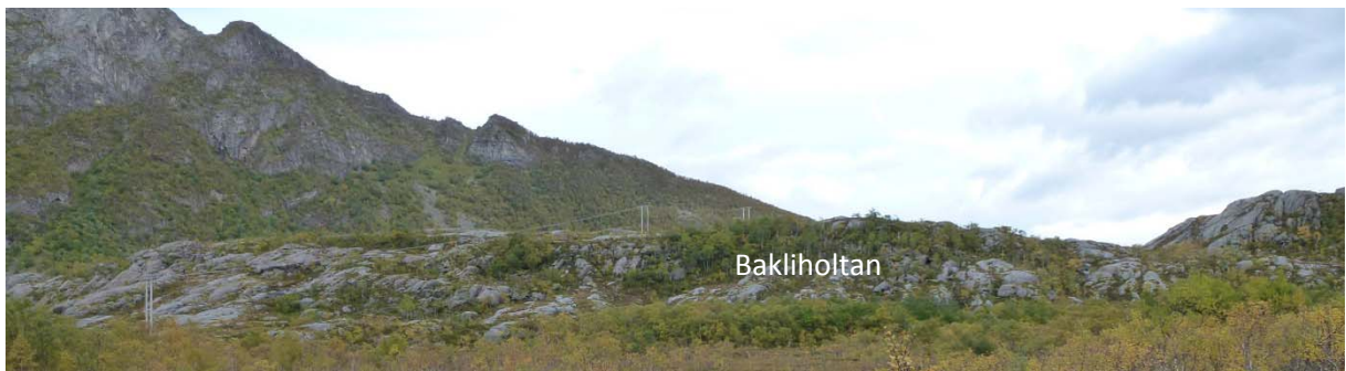
Figur 23. Høyspentlinje over Liamyra og opp mot Bakliholtan.
