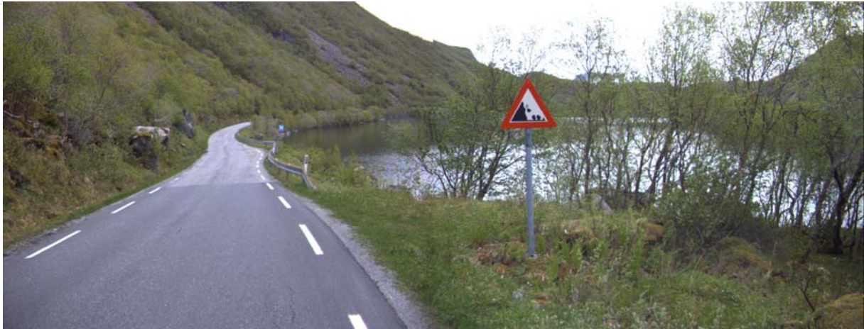
Figur 4. Veg ved Olvikvatnet. Fareskilt som viser steinsprang.
