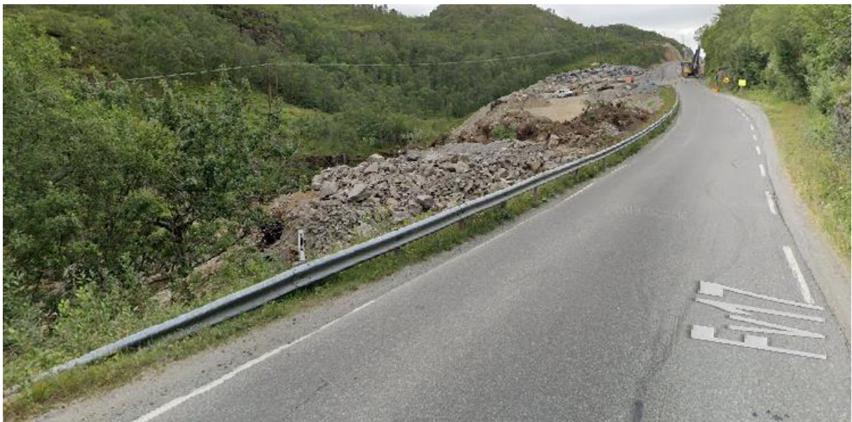
Figur 25 Massedeponi ved fv. 17 (ViaPhotoSVV).
