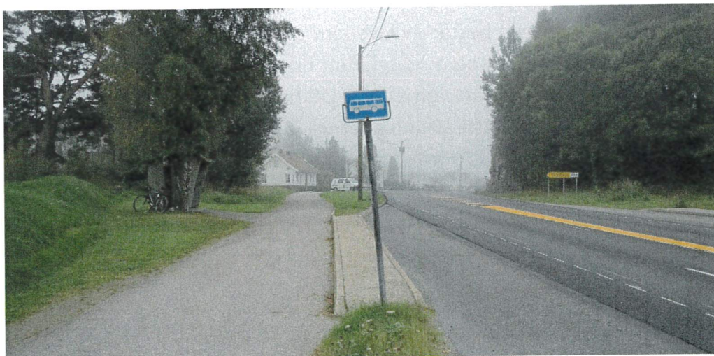
Figur 12. Reposet ved holdeplassen på østsiden av Hølleveien er smalt, og ikke universelt utformet. (SVV)
