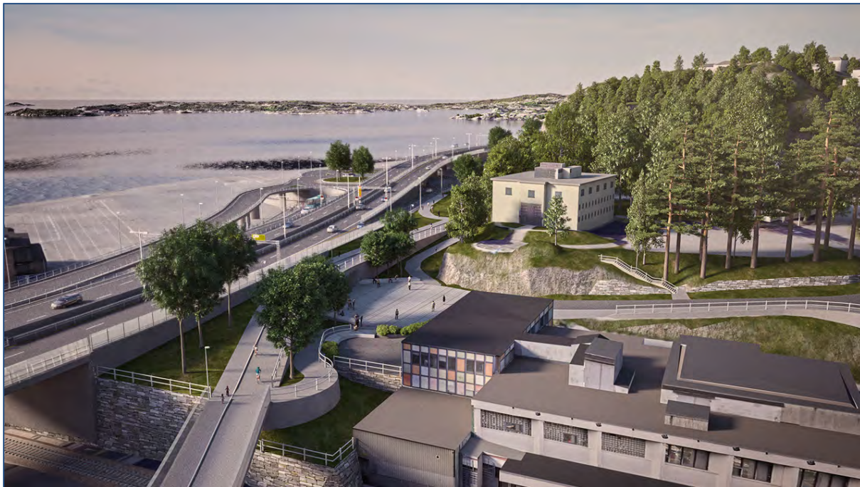
Figur 18: Sykkelekspressvegen krysser jernbanen i separat bru, sett fra øst ved kirkegården over mot Arkivet. Ved Samsen er det forbindelse til Møllevannsveien, og til sentrum under E18/E39 og langs Havnegata. Konstruksjonen for kjørebrua er en mye tykkere konstruksjon enn gang- og sykkelvegbrua. Bruene holder samme fri høyde over jernbanen i forhold til underkant bru.
