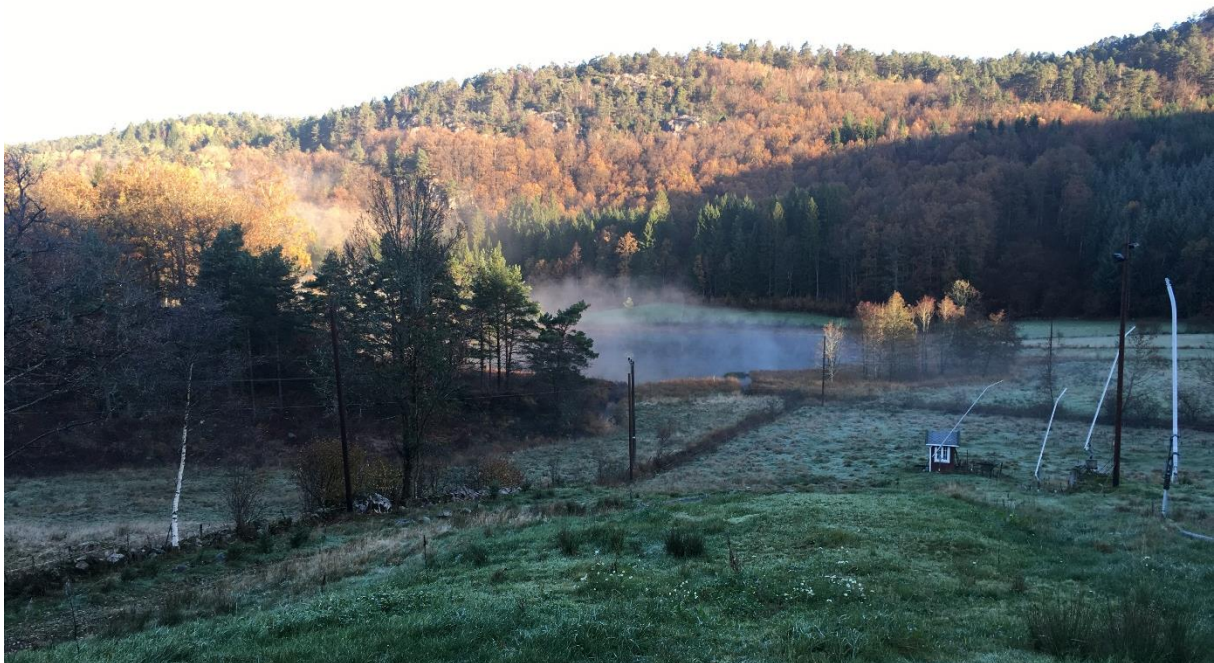
Figur 5-3. AB Sør går i fylling over sørenden av Holtetjørn nedenfor alpinbakke. Foto: Sweco Norge.
