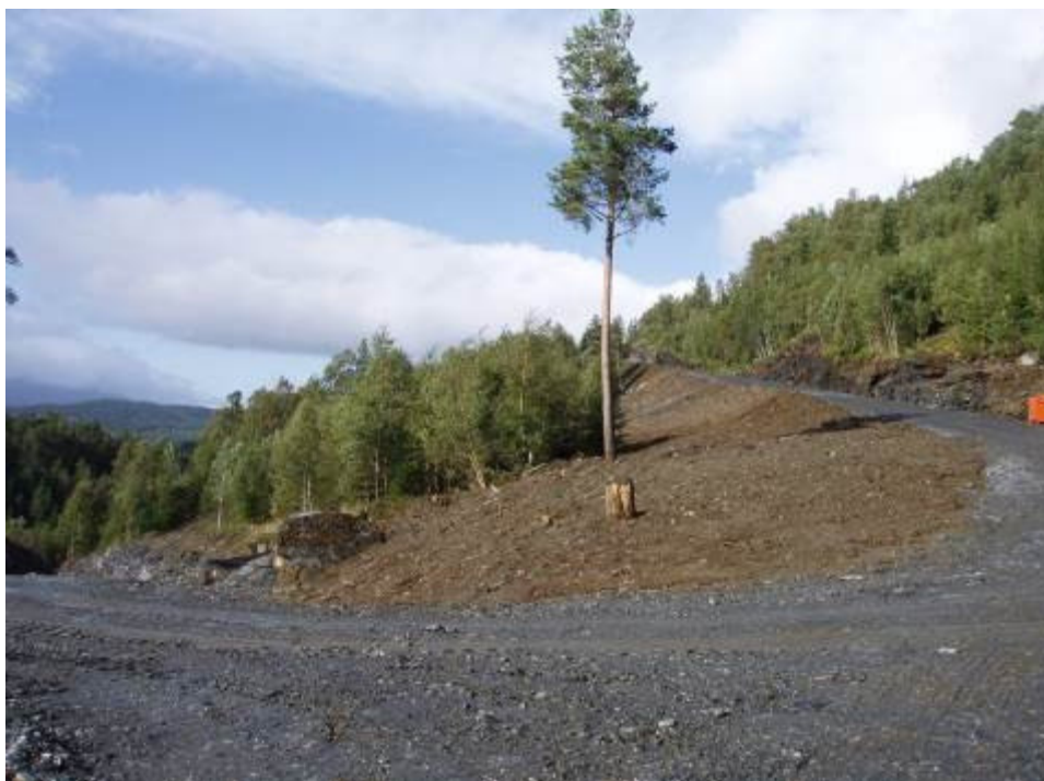
Figur 5.10.2: Kvitnamarksvegen, ca 2,5 km, går frå Fv.310 og opp til hyttefeltet. Infrastruktur som VA-leidningar og høgspenkabel er ført fram til hyttefelt langsetter vegen.
