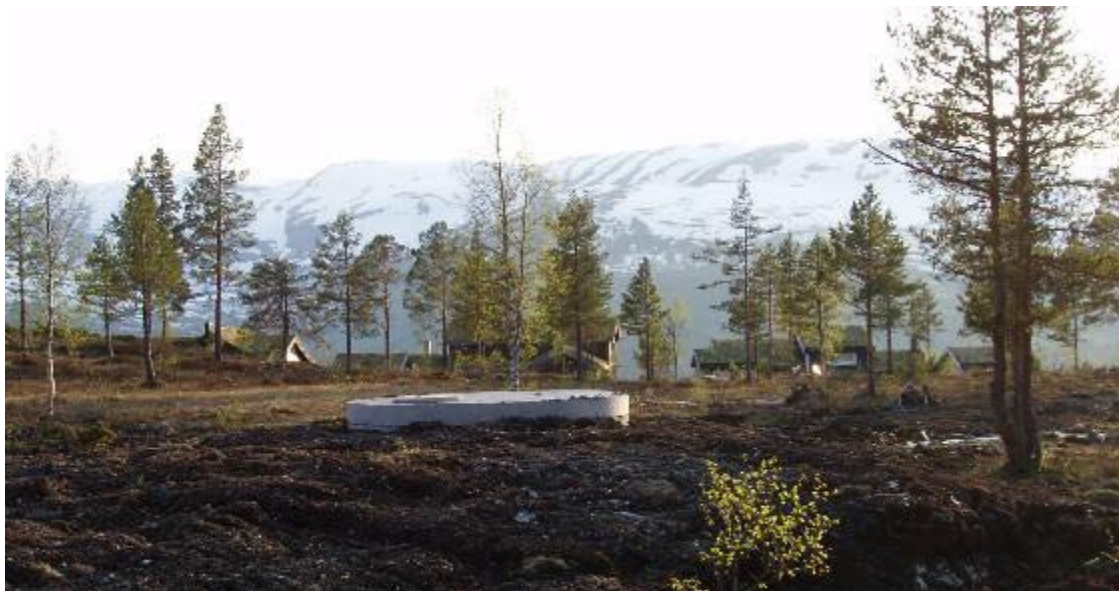
Figur 5.14.1: Biletet viser brønn/høgdebasseng på Litrane
