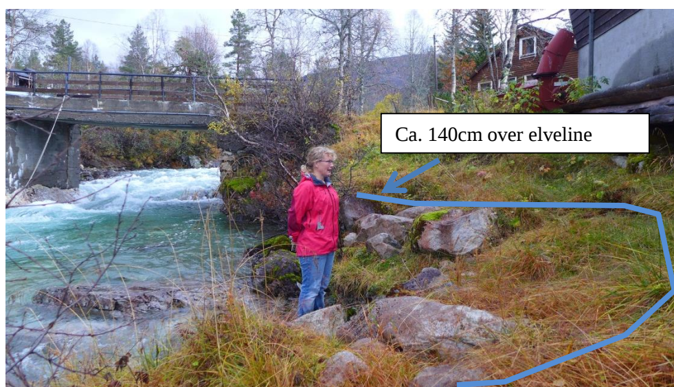
Figur 16 Bilete som viser tydeleg nyare erodering av elvebreidda på ca. 140 cm over elvekant.
