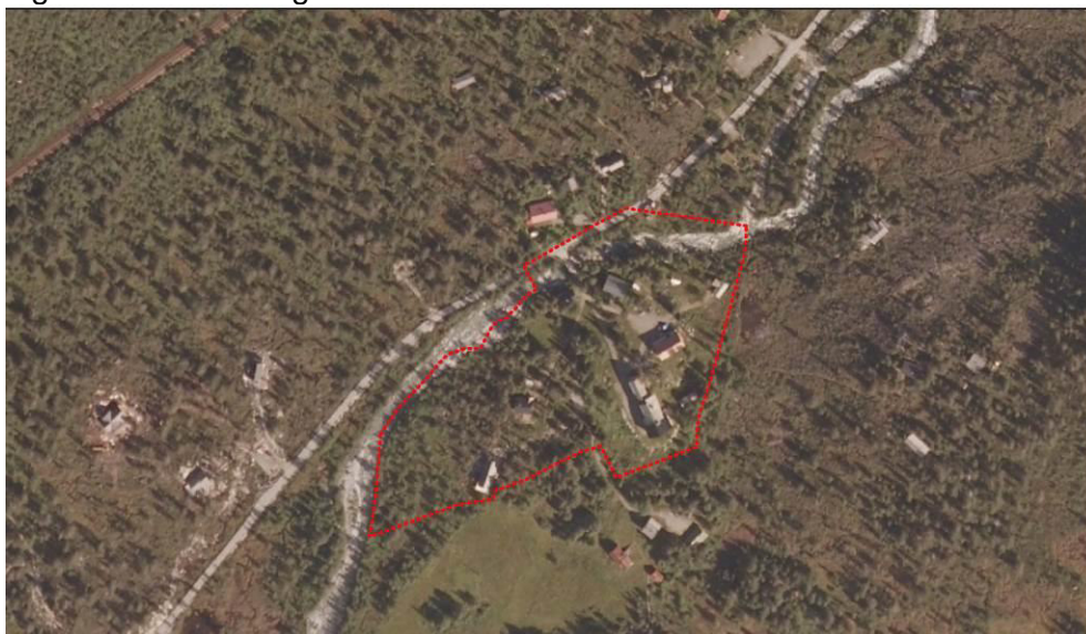
Figur 5.4.a: Flyfoto over planområdet. I venstre hjørne kan ein sjå Bergensbanen som går gjennom heile Raundalen. Fylkesveg 307 og elva Ljosåni midt i biletet.
