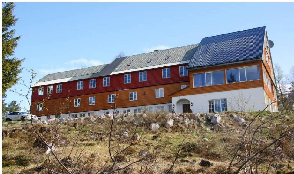
Figur 5.3.a: Hovudbygningen til Kårdal pensjonat, fasade mot sørvest.
