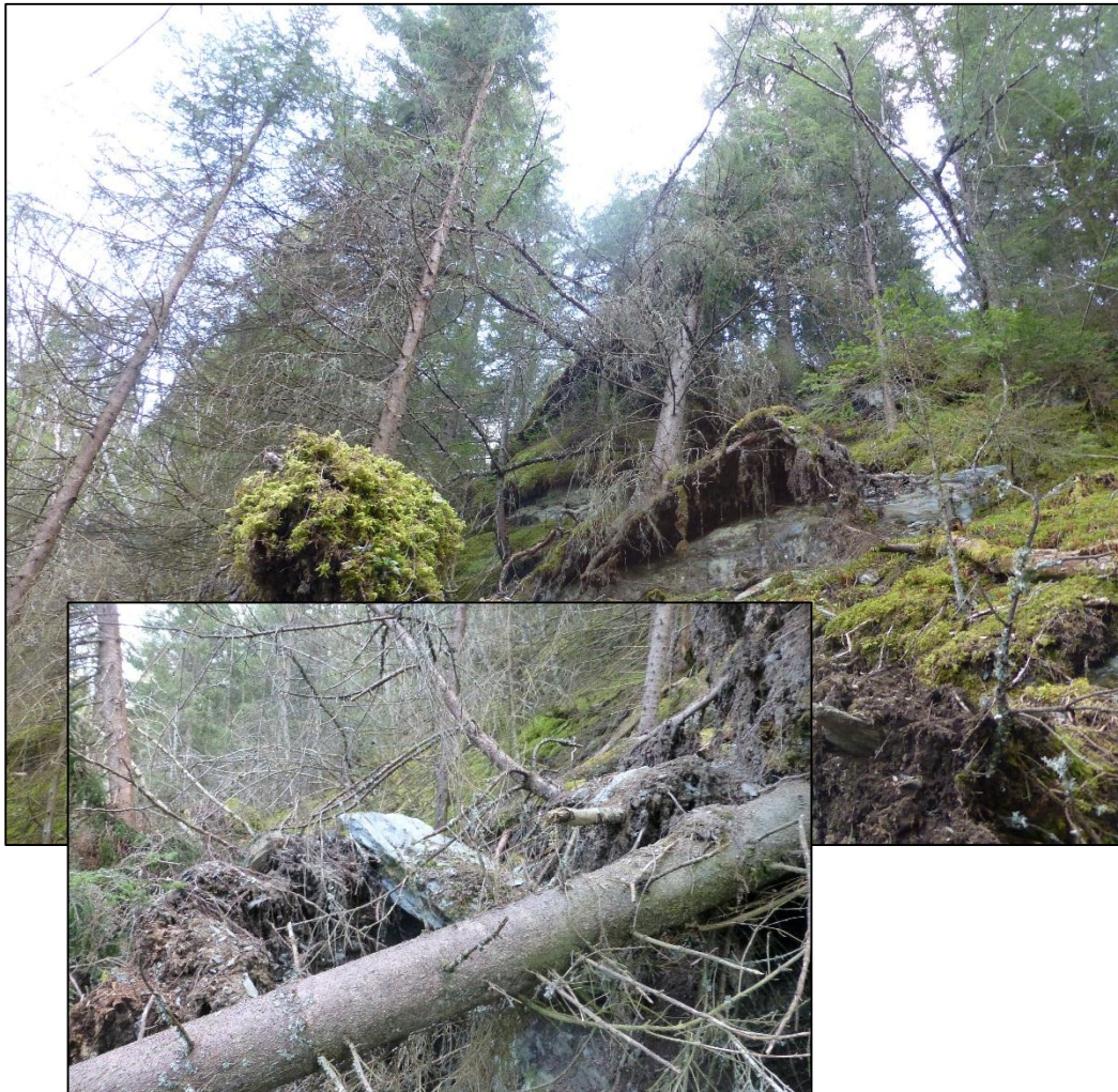
Figur 8: I skråningen sør for Kjoldmyra er det observert flere rotvelt og løsriving av steinblokker på grunn av rotveltene.
