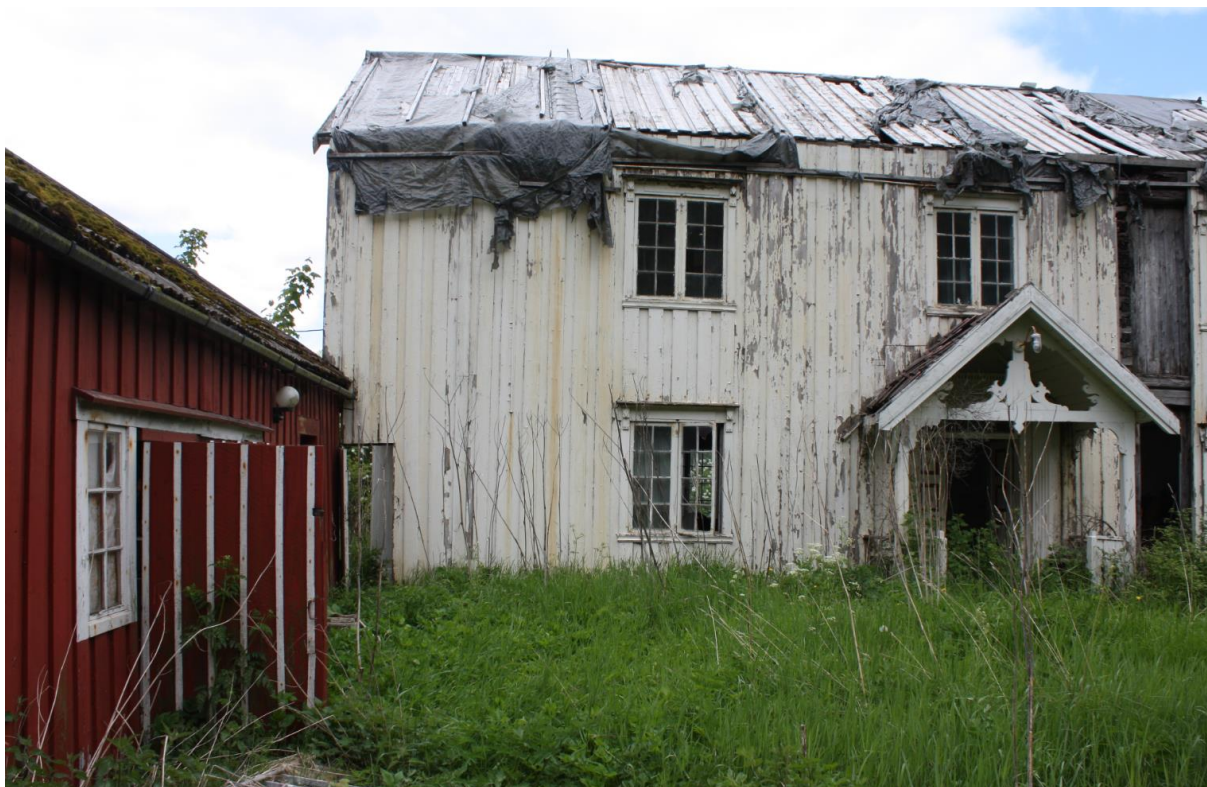
Våningshus og mastu (i takstrapporten benevnt som tidligere bolig 2)
