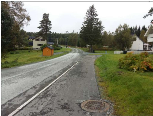
Figur 3: Eksisterende gang- og sykkelveg sett fra Hølundvegen.
