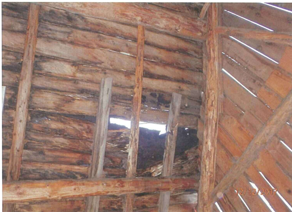
Utett tak inn mot gårdsplass, råte i konstruksjon.
