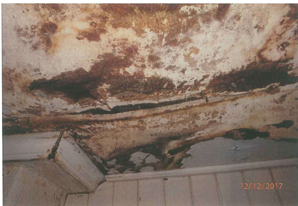
Fukt i himling ved pipe, 2 etg.
