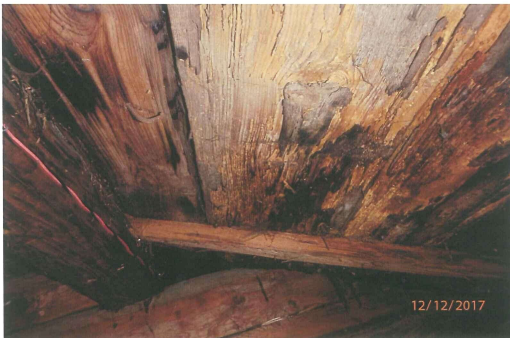
Råte i taktro
