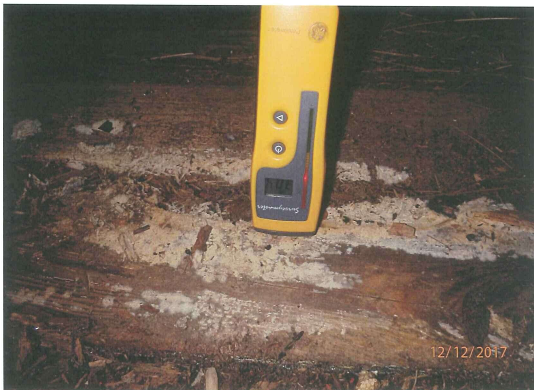
Sopp, råte og fukt i gulv under taklekkasje.
