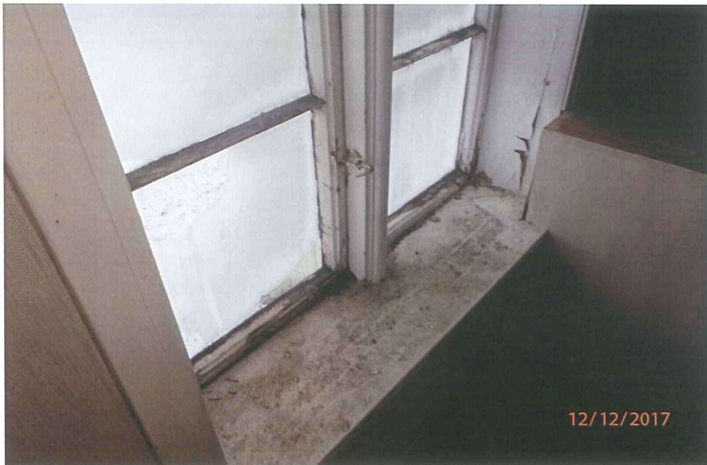
Fukt og råte i vinduer.
