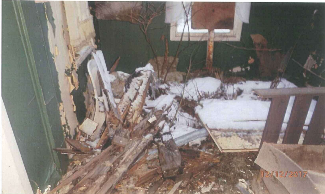
Kjøkken er uten tak på tilbygg. Nedbør etc kommer direkte inn.
