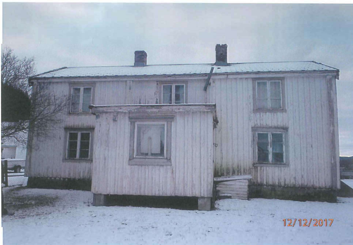
Tilstandstrapport Østerdalsvollen 8. 7224 Melhus NS-EN 16096 Tilstandsanalyse av fredete og verneverdige bygninger.
