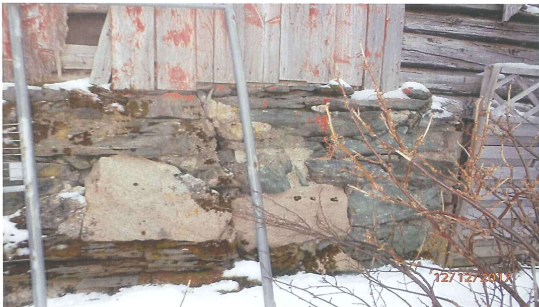
Bildet viser skjøt mellom første del og del to på stablet gråsteinsmur. Muren er stabilisert med mørtel.
