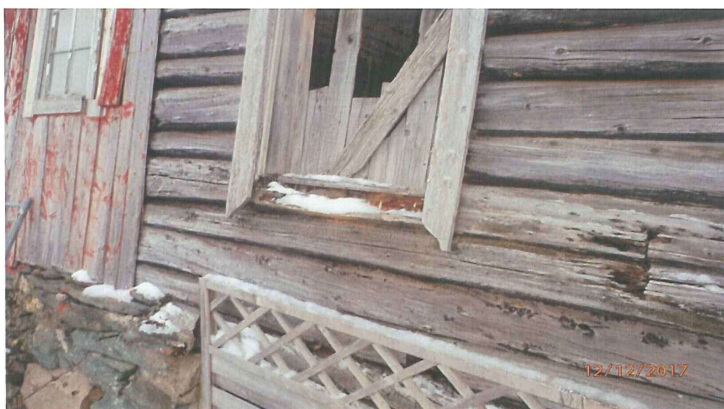
Råte i laftet vegg. Manglende vindu. Gråsteinsmur er utglidd.
