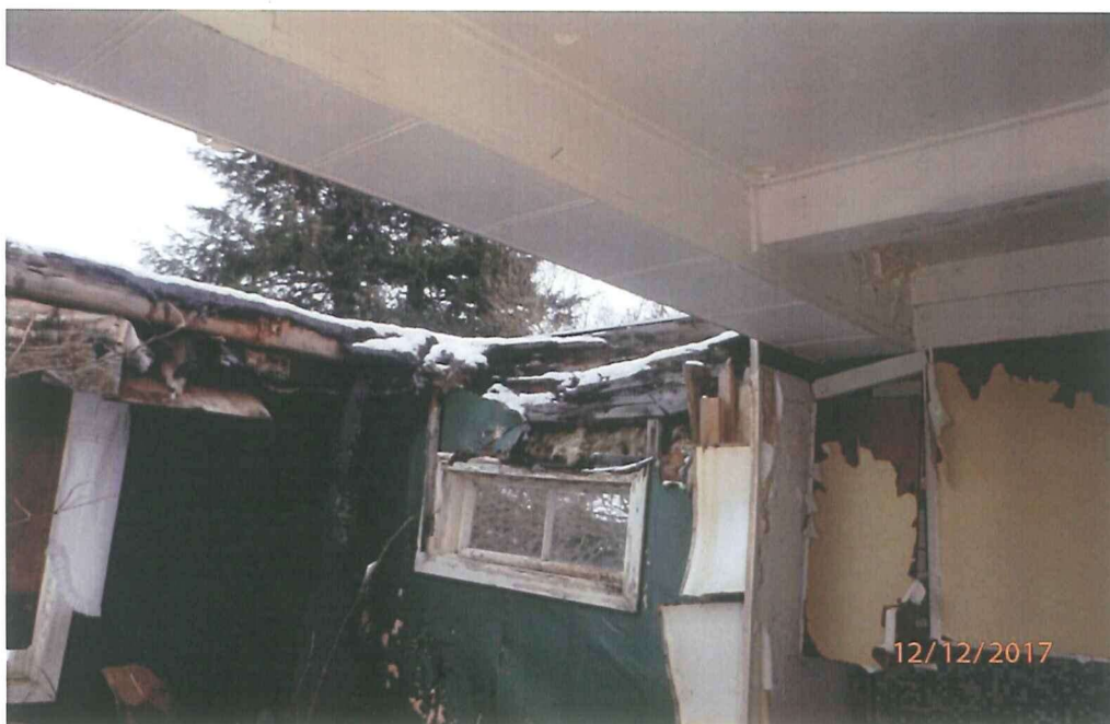
Takkonstruksjon på kjøkken er borte.
