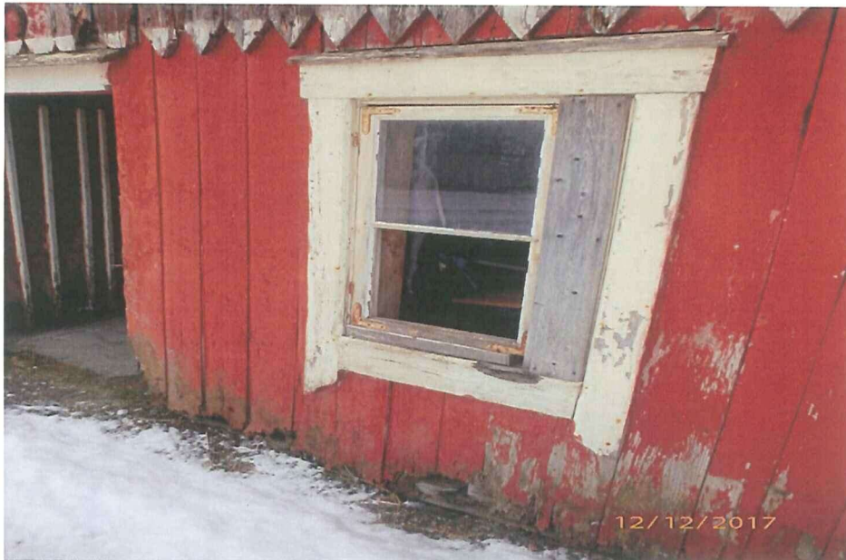
Bilde viser råte i kledning, vindu er erstattet med mindre vindu. Glass mangler
