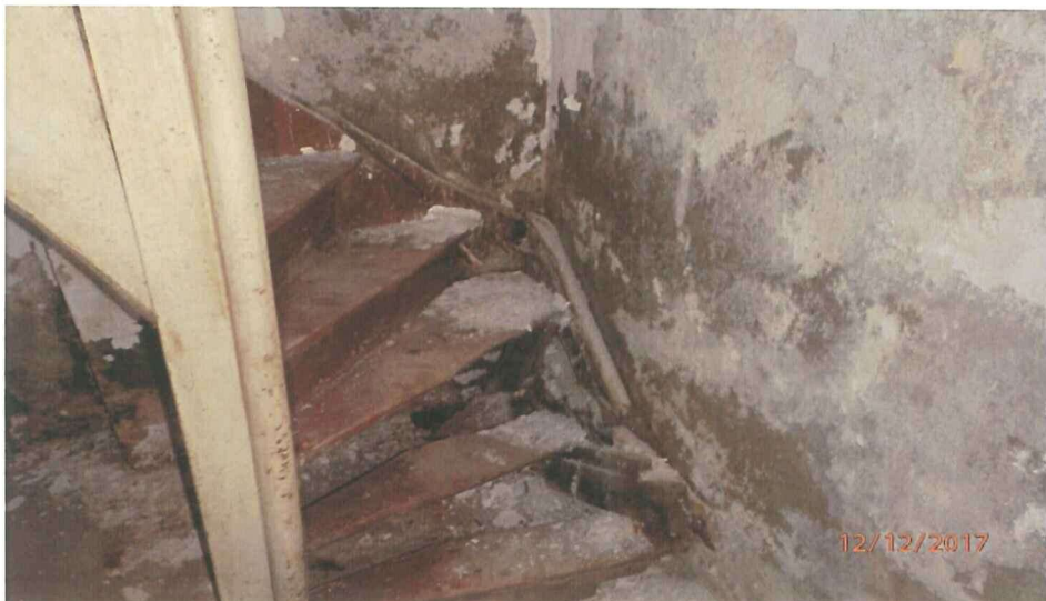
Råte i kjellertrapp
