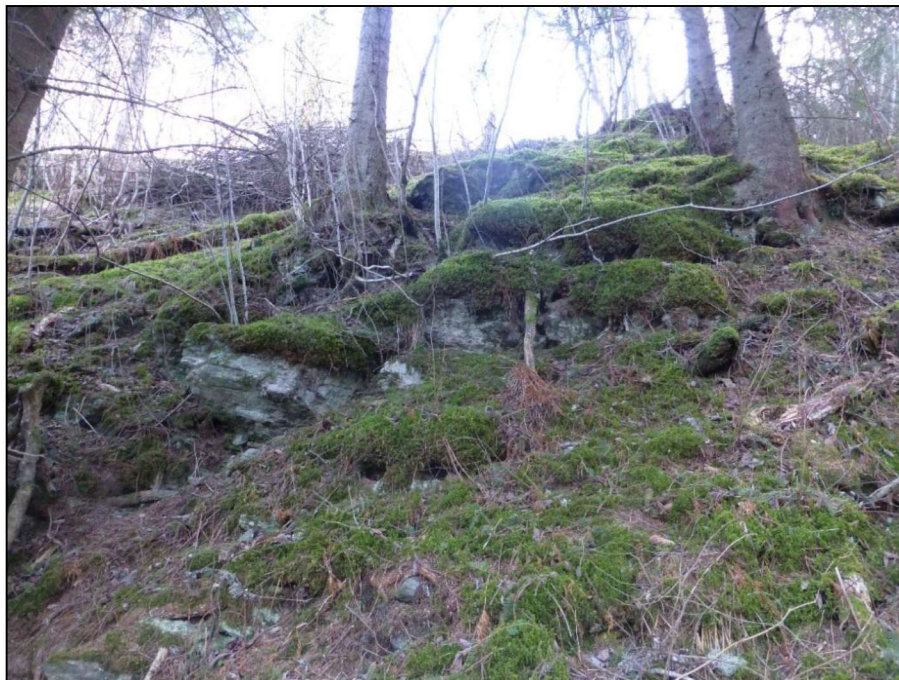
Figur 6: Bergblotning i skråning innenfor aktsomhetsområde for jord- og flomskred. Tynt løsmassedekket av forvittringsmateriale og morene er observert i skråningen.
