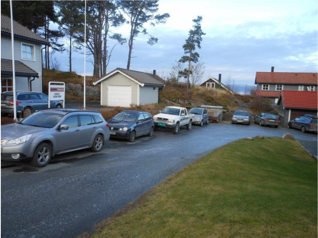
Ved Trafo og garasje
