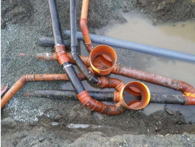
Figur 2: Stikkledninger til Lassbergveien 10 fra kummene 65937/65938
