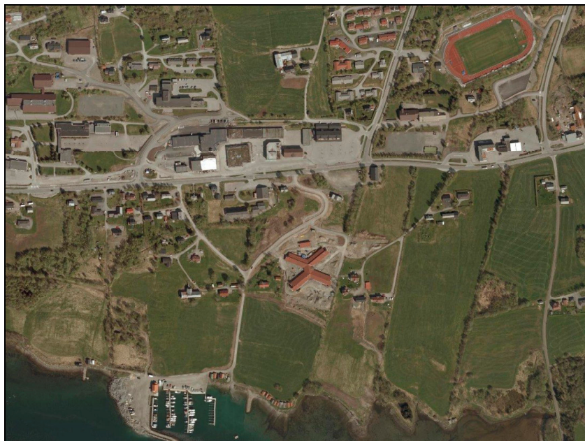
Flyfoto av sentrum tatt under bygging av sjukeheimen i 2007/2008
