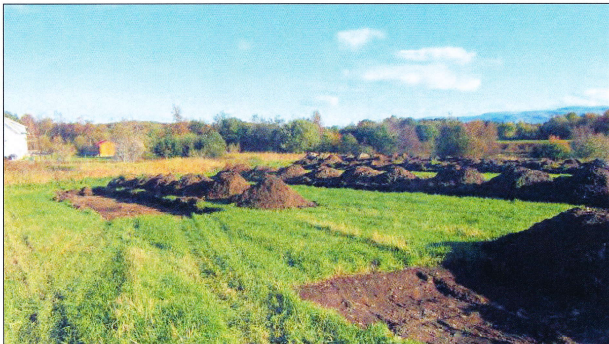
Sjakter i dyrka mark i nordøstlig del av planområde. Dette området bestod av tørr og relativt steinfri masser.
