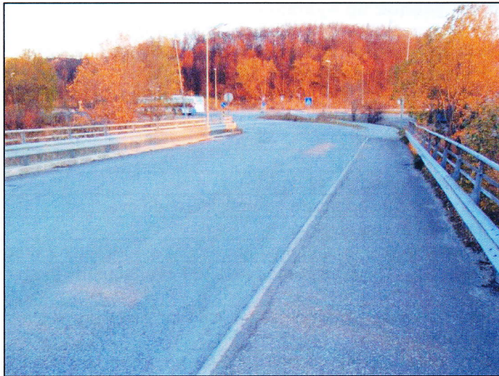
Figur 39 – Broen sett mot syd
