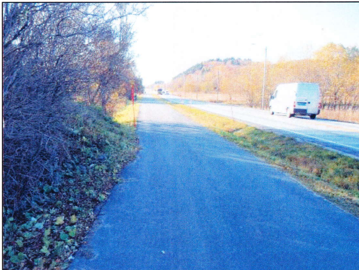
Figur 21 – G/S-vegen langs rv. 80 fremstår som oversiktig, sett mot vest
