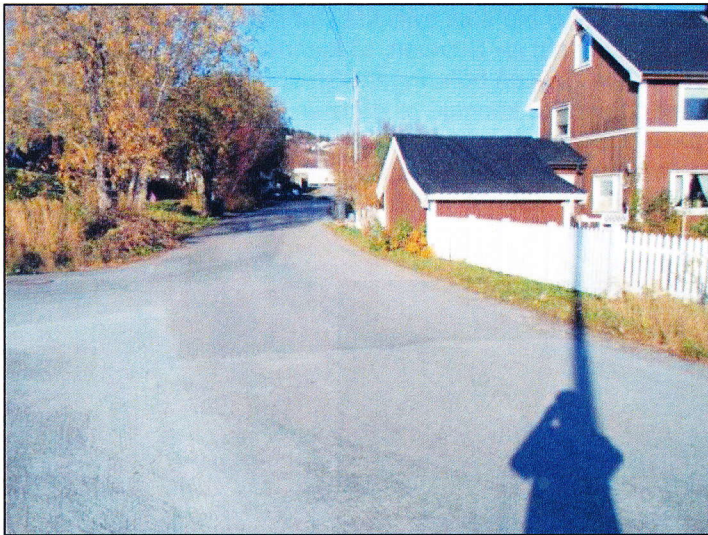
Figur 12 – Fenesveien sett mot nord
