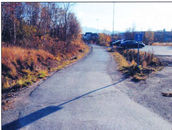
Figur 32 – G/S-veg mellom Mørkvedveien og gangbro, sett mot syd
