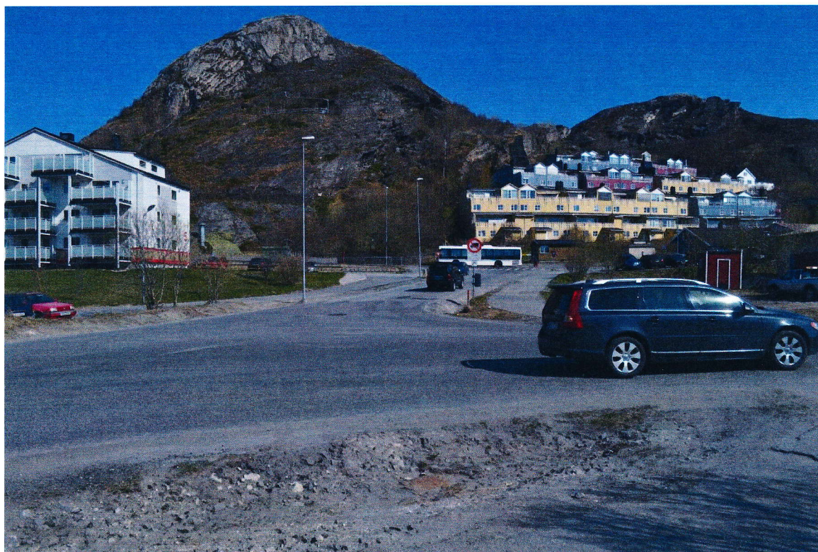
Krysset Burøyveien – Nordstrandveien (fv. 834) og krysset Jernbaneveien-Burøyveien (nærmest)
