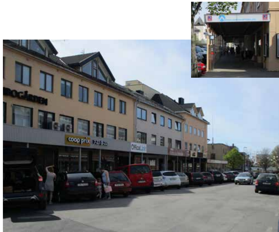
Takoverbygg mot Storgata i kvartal 1.17
