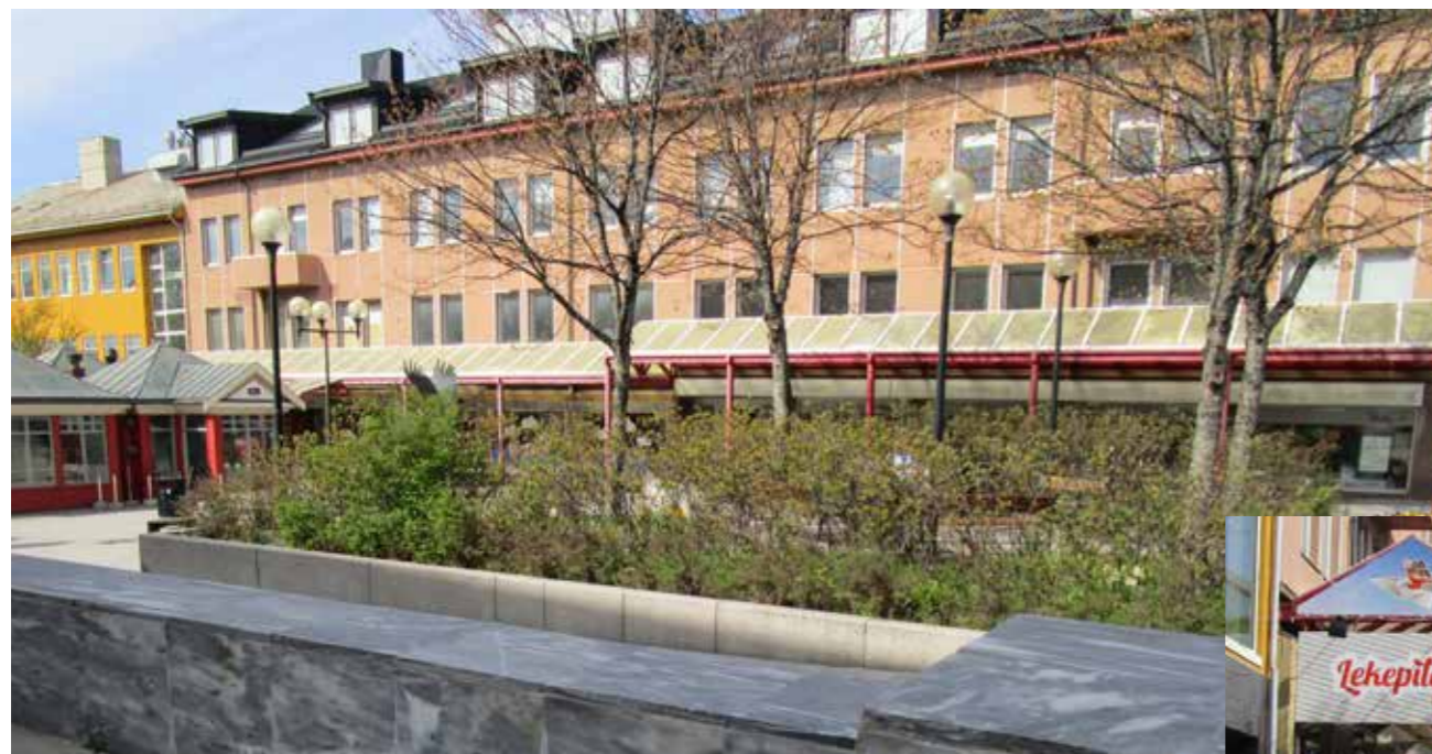
Takoverbygg mot Storgata i kvartal 1.10
