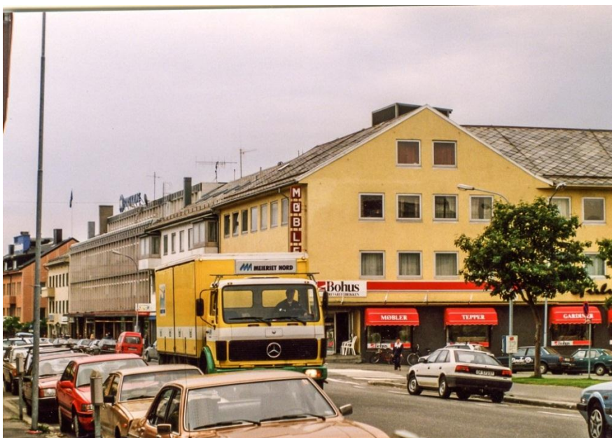
Figur 32. Foto trolig fra 1980-tallet viser bygget uten takopplett. Kommunens arkiv.
