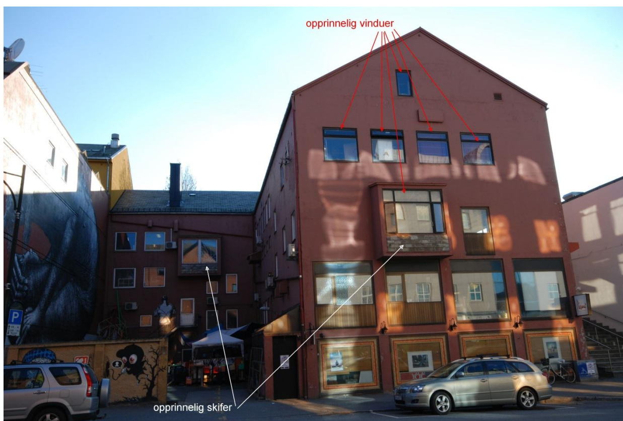
Figur 11. Fasaden mot Sjøgata med piler som markerer opprinnelige elementer. Norconsult 2014.
