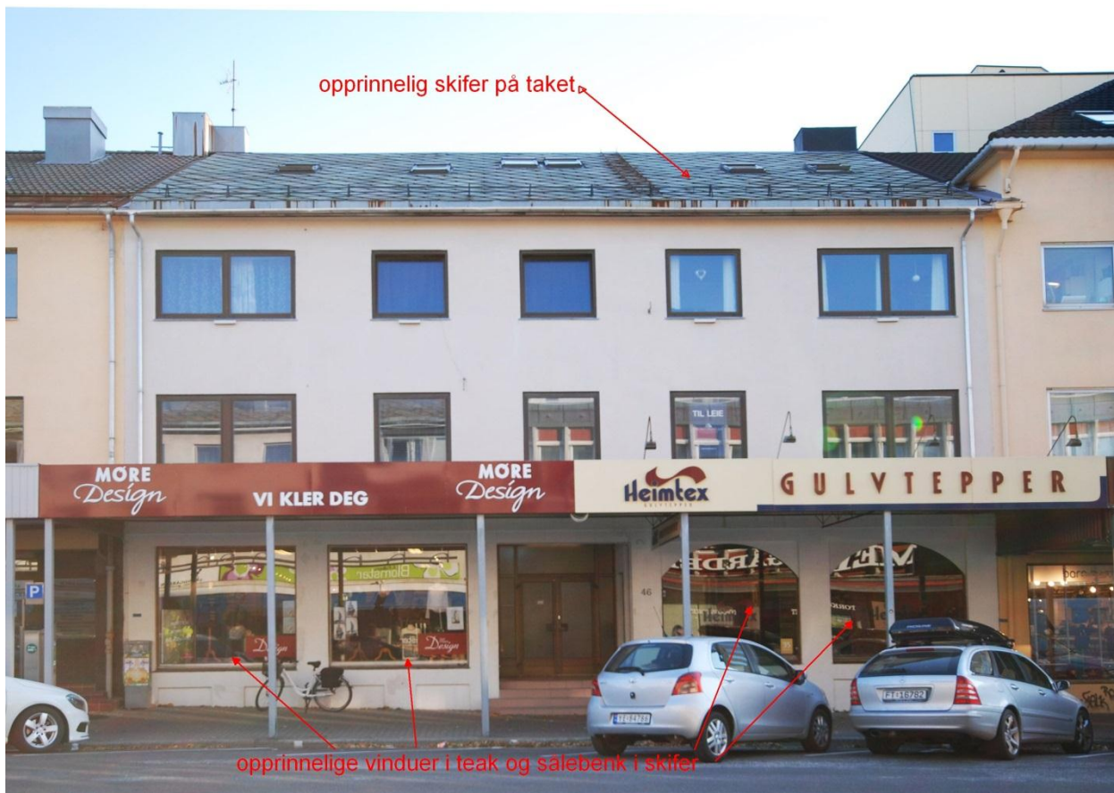
Figur 57. Foto av bygget med inntegnet opprinnelige elementer. Foto Norconsult 2014
