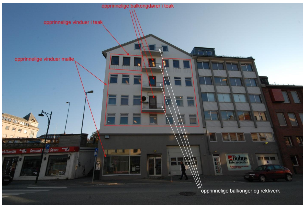
Figur 30a og b. Foto med inntegnet piler som viser til opprinnelige elementer. Norconsult 2014.
