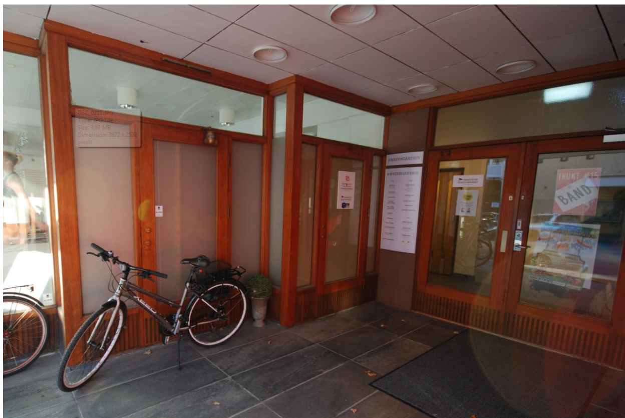
Figur 24. Inngangspartiet med opprinnelige kvaliteter. Norconsult 2014.
