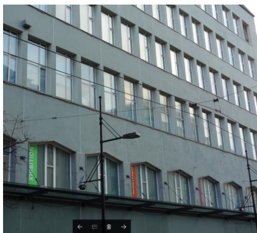
Eksempel på baldakiner montert på fasade. Glass uten søyler.
