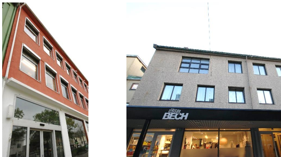
Figur 15: Eksempel på fasader som er etterisolert på utsiden. Fasadens opprinnelige uttrykk blir forringet når vinduene trekkes inn i fasadelivet
