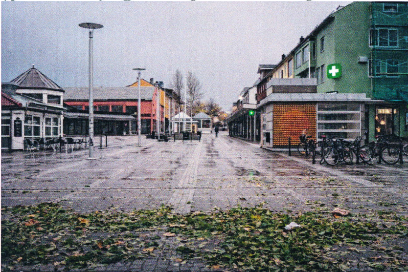
I senere tid har byggene i stor grad fått tilføyelser både på tak og fasader. Det er også flere elementer i gateløpet som gir et uryddig uttrykk, og som gjør at området ikke fremstår som en helhet.
