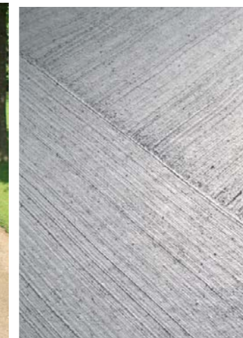
Belægning Betonoverflade, struktur/kostet
