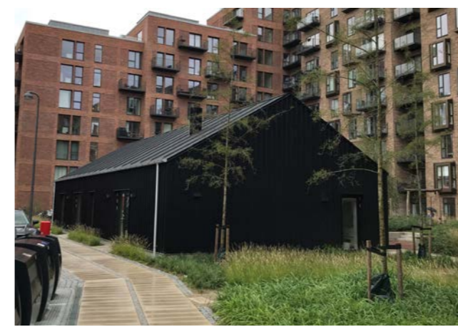
Fællesfunktioner fx. cykel-p, fælleshus mm. Udføres i maritim stil og gerne med træbeklædning.
