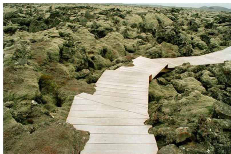
Præcis udlagt element i stenfylling - stier i stenfyllingen
