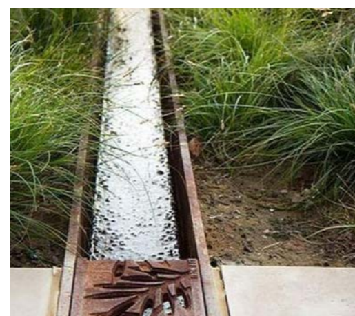
Regnvandshåndtering som rekreativt element Synlig og styret regnvandshåndtering benyttes som rekreativt element i gårdrummene
