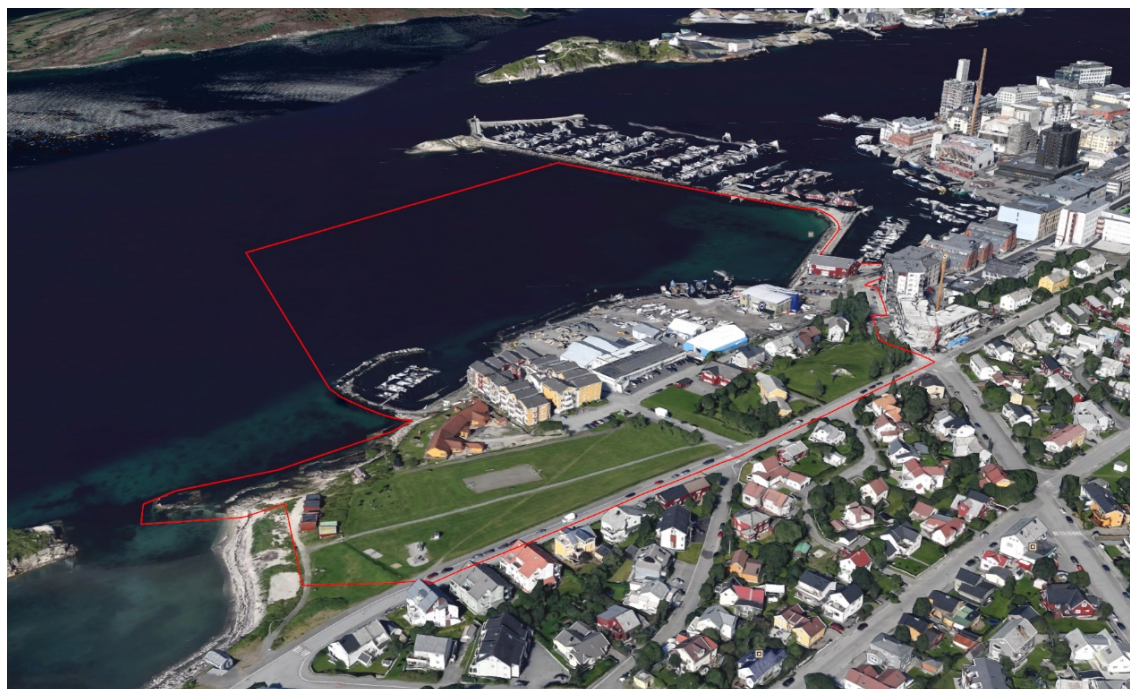
Figur 9- Flyfoto som viser eksisterende bebyggelse og anlegg innenfor planområdet. Kilde: Google Earth.
