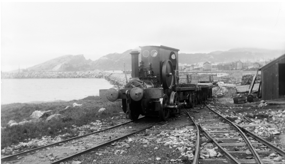
Figur 9: Lokomotivet «Putten» og jernbane for fraktning av stein ved etableringen av moloen. Bildet er tatt i 1904. Kilde: Gamlebodo.com
