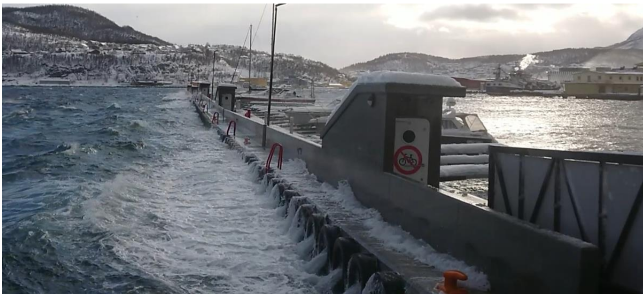
Figur 16 Flytemolo i Harstad under moderat bølgebelastning. Elementene er så store at det er lager-rom inne i hver enhet med trappehus som vist på bildet. Flytemoloen er effektiv for å fjerne skumtopper og skavl fra bølgene, for bølger med periode over ca T = 5.0 s er bølgene nesten upåvirket.
