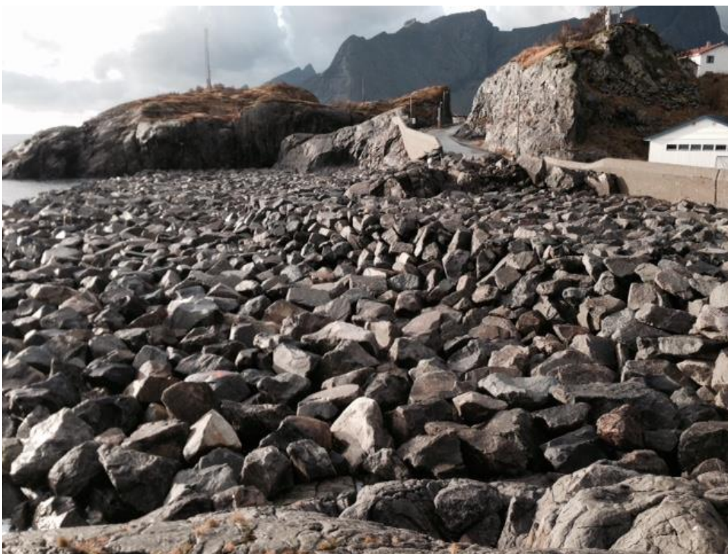
Figur 17 Eksempel på utradisjonell løsning med en lav brei skulderfylling ved Hamnøy/Reine, E10 i Lofoten
