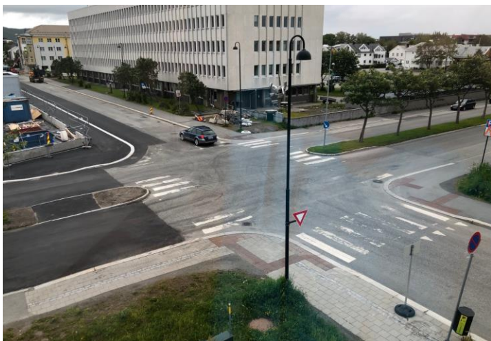
Figur 19: Bilde av krysset mellom Hålogalandsgata og Prinsens gate
