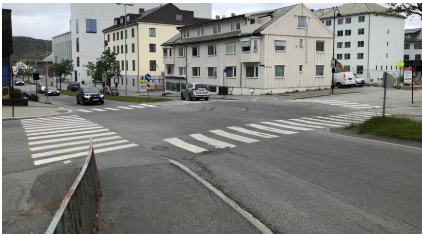
Figur 23: Bilde av krysset mellom Hålogalandsgata og Moloveien/Dronningens gate.
