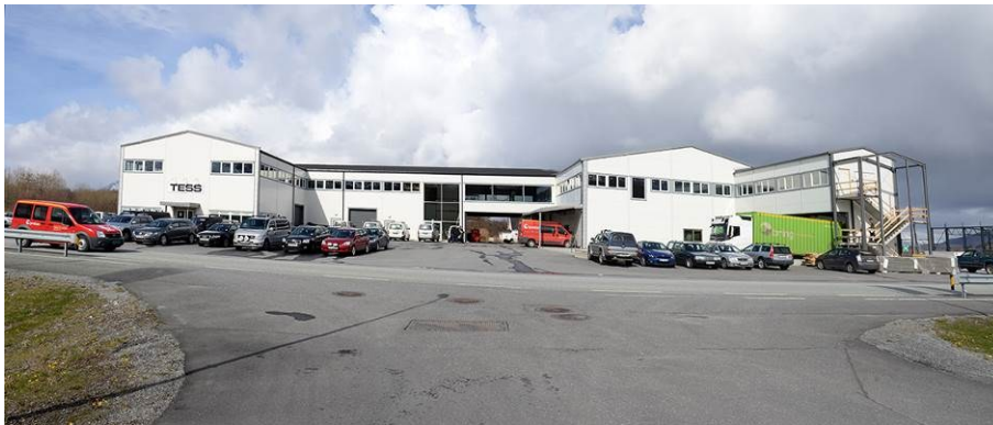
Figur 5. Dagens situasjon av prosjektområdet. Bildet er tatt mot forsiden av bygget.
