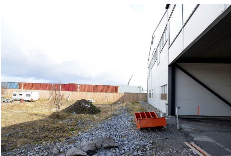
Figur 8. Bilde av dagens situasjon. Bildet er fra baksiden av bygget og tatt mot øst.
