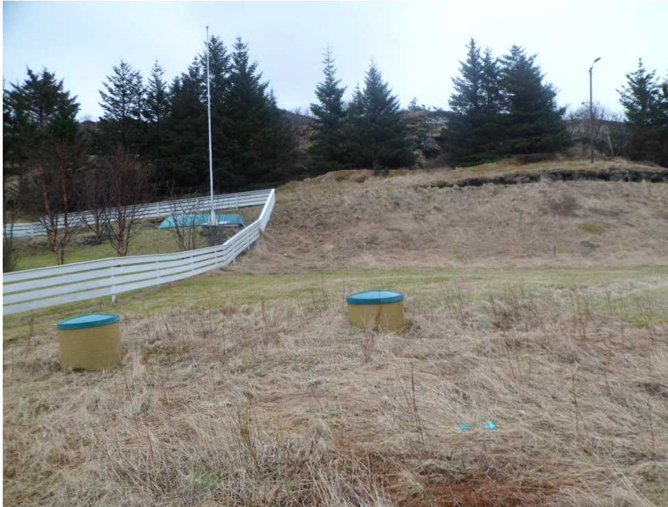
Figur 3 viser deler av byggeområdet
