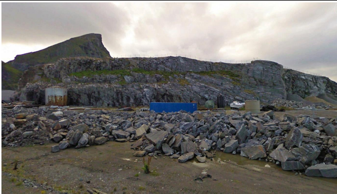
Fig. 21: Berget på Naustholmen - sett mot vest fra Naustholmen. I bakgrunnen fjelltoppen Billringen på Lovundfjellet. Krykkjeberget på Naustholmen, til høyre i bildet, blir stående igjen etter sprengingstiltaket.
