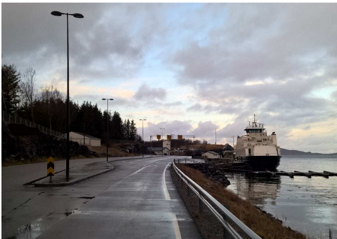
Figur13. Oppstillingsplass fergeleie etter ombygging
