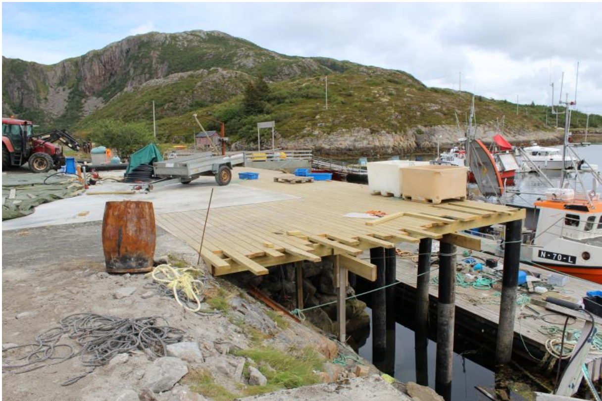
Figur 12. Bygging av mer kaiareal per i gang
