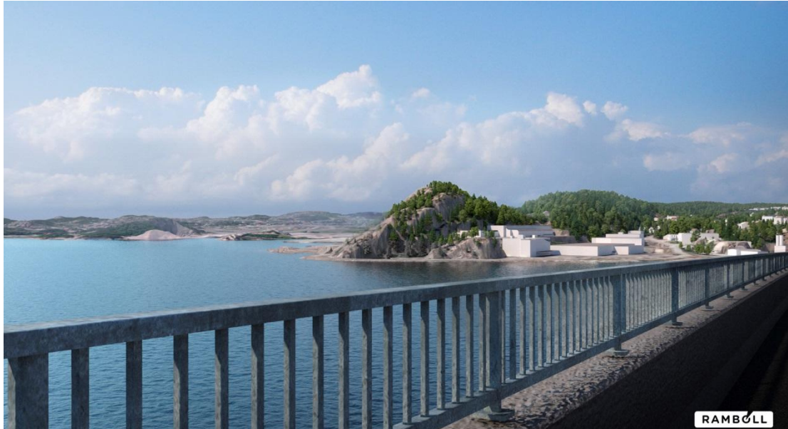
Figur 18 Fra Varoddbrua – eksisterende situasjon
