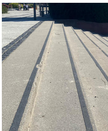
Trappeneser med termoplast, gatestein i overgang
