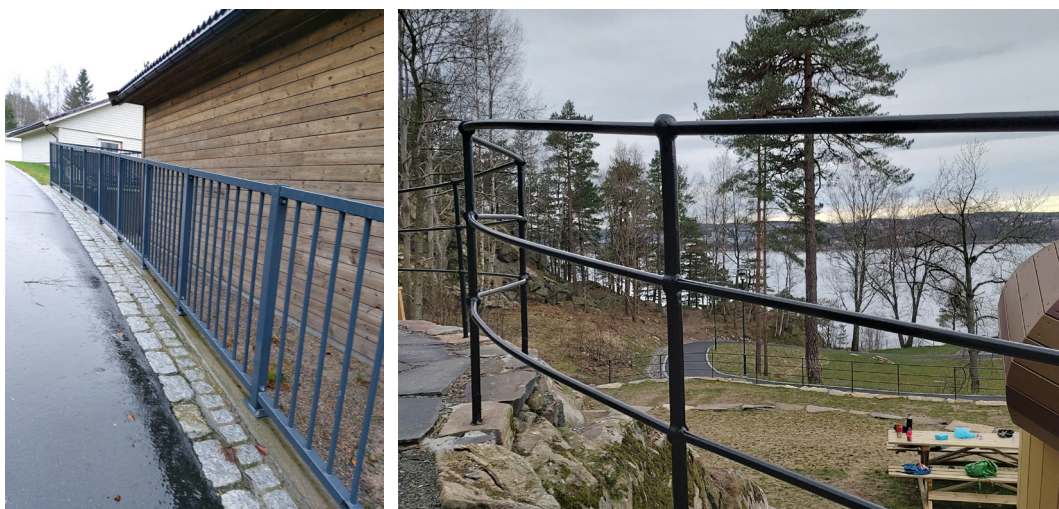
Eksempler på utførelse: klatresikkert rekkverk (Torridal gravplass) og «Sørlandsrekkverk» Peisestua på Odderøya.
