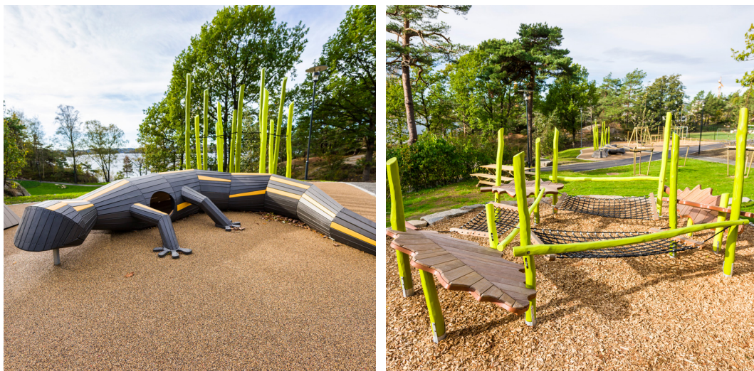
Fallunderlag av plassøpt gummi til venstre og hoggeflis til høyre, begge mot fast kant. Merk at hoggeflis skal ligge litt lavere enn kantsteinen. Merk også innfesting av trematerialer på galvanisert fot. Peisestua lokalpark, Odderøya. Foto: Kjell Inge Søreide.
