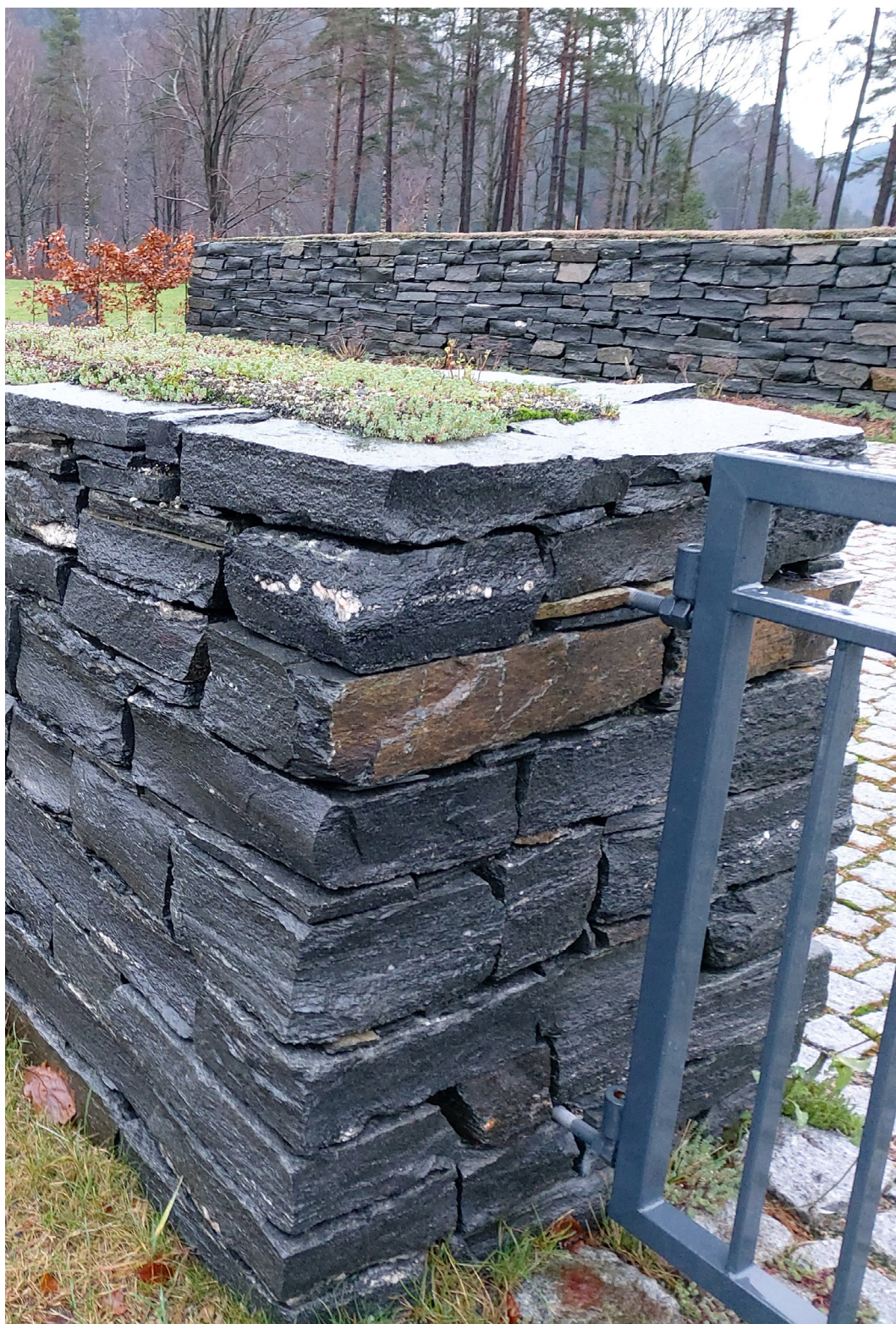
Referansebilde: Tosidig tørrmur med sedummatte, høy kvalitet. Øvre steinsjikt, ca. 30 cm, er bundet sammen med mørtel. Torridal gravplass 2020.
