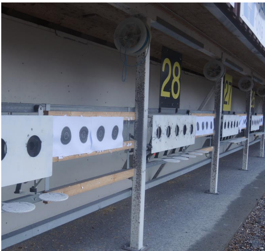
Figur 7. Fra Knyken skisenter i Orkdal. Skiver og kulefang står på fast dekke og er overbygd.
