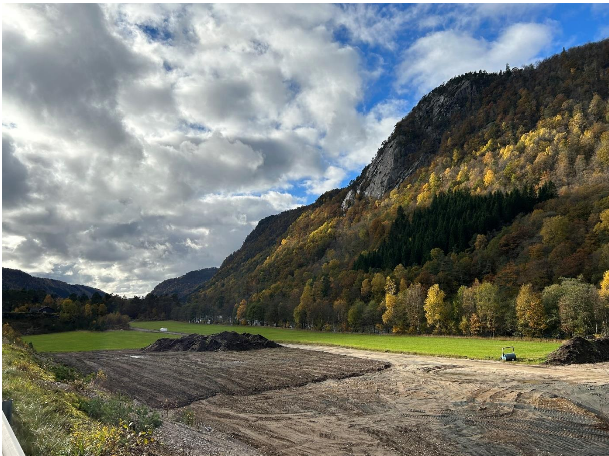
Figur 11 Reetablering av jordbruksareal etter endt uttak av sand på eksisterende uttaksområde nord for planområdet
