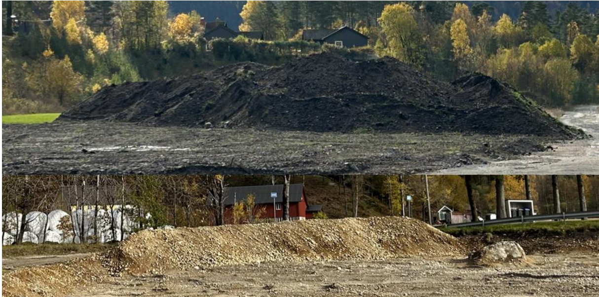
Figur 12 Illustrasjon på hvordan matjord og undergrunnslag rankes opp mens uttak av sand pågår.
