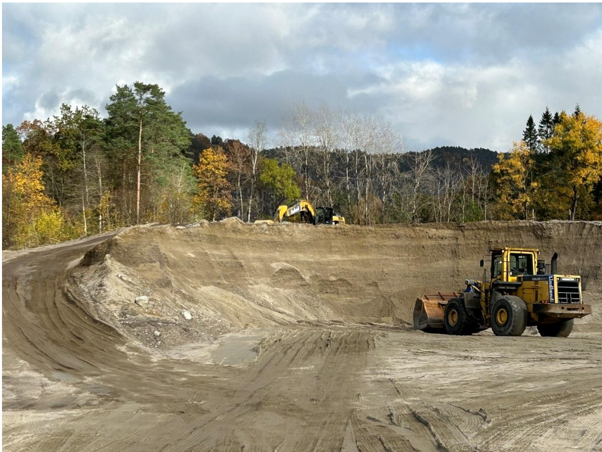
Figur 19 Illustrasjon som viser hvordan hjullasteren arbeider naturlig skjermet i uttaket
