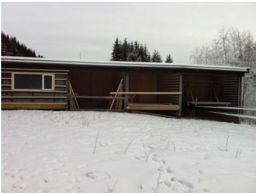
Figur 2-2: Bilde av standplass, isolert overbygg.
