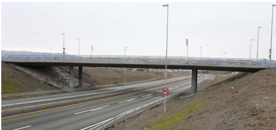
Figur 7-10: Overgangsbruer i kryss er planlagt å bli tilsvarende de som er bygd på E6 Stjørdal.
