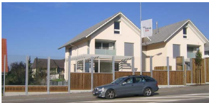
Figur 24: Støyskjermene utformes som vist på bilde med hensyn på materialvalg og utførelse.
