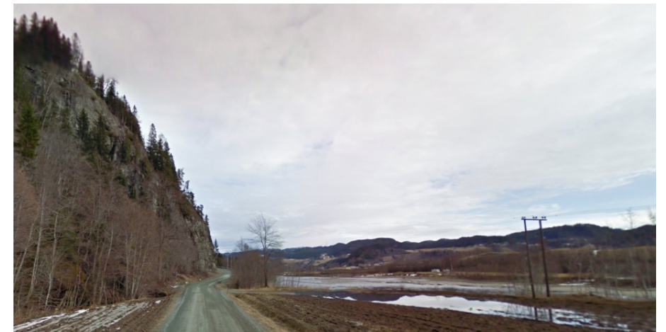
4- Kleivhammaren – Selv om dalen er vid og åpen er det trange vanskelige partier som her. KU viser ny E6 mellom hammer og Gaula. Tunnelen forlenges for å unngå inngrep i hammeren og fylling i elva.
