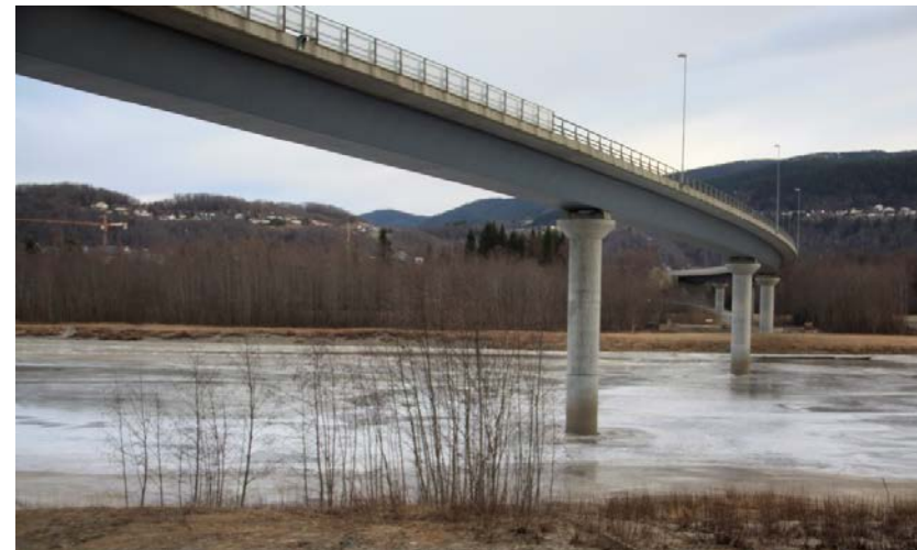
Melhusbrua er inspirasjonen for de 2 store motorveibruene. Den er lett og slank. (Foto: Bjørnar A. Larsen)
