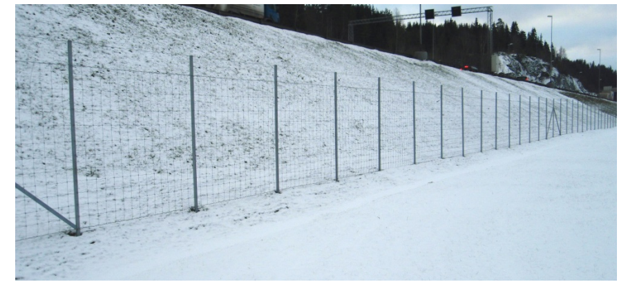
Viltgjerde plasseres minst 10 m fra hvitstripe. Det skal stå minst 3 meter innpå skrånings- / skjæringstopp. (Foto: Heras Norge AS)
