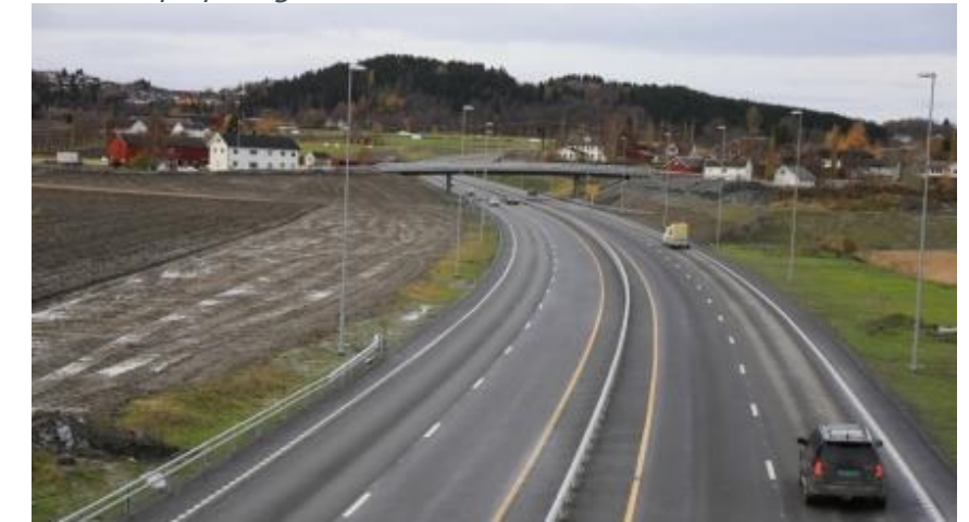
Nye E6 Stjørdal– Kvithammar er bygd med de kvalitetene som planlegges for E6 Røskaft – Skjerdingsstad. (Foto: Bjørnar Larsen)
