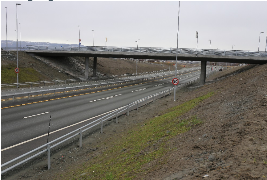
Overgangsbruene på kryssene på Ler og Skjerdingsstad blir som vist på bildet. Bildet er fra E6 Kvithamar (Stjørdal) (Foto. Bjørnar Alvin Larsen)
