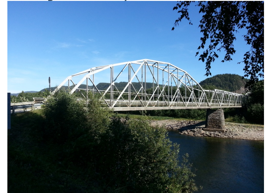
Eksisterende lokalvegbru over Gaula ved Lundamo er fagverksbru med bue og kasse. (Foto Hanne Mørch)
