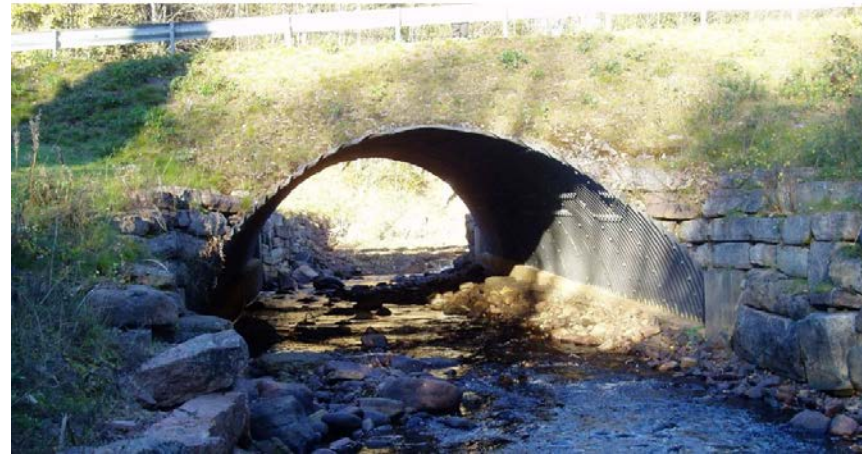
Bekkene føres gjennom vegen i en kulvert med grus og som samtidig skal ha en tørr kant som små dyr kan gå på. Det er planlagt betongkulverter på strekningen og ikke rørkulvert som på bildet. (Foto: Hanne Mørch)
