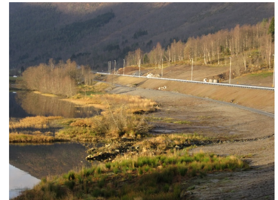
Myke overganger, utslakking, og oppstramming av vegfylling er virkemidler som brukes for å forankre ny E6 mellom Røskaft og Skjerdingsstad til eksisterende terreng. For eksempel med 1:4 helning på fylling og utslakking 1:7 mot dyrkamark, bruffyllinger med avrundinger som formes etter den overordnede landskapsformen og gjennomgående grønn grøft som skaper rom mellom veg og støyskjermer. Foto: Hanne Mørch)
