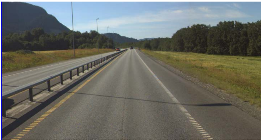
På E6 Røskaft- Skjeringstad er sideterrenget lagt med helning 1:4 de fleste steder slik at behovet for rekkverk skal være på et minimum. Midtdeler er ett-rørs-rekkverk slik som på tilgrensende parsell på Melhus, men i styrkeklasse H2.
