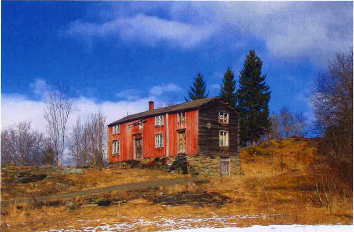
Gammellåna på Rønningstrøa er den siste bygningen som står igjen på tunet
