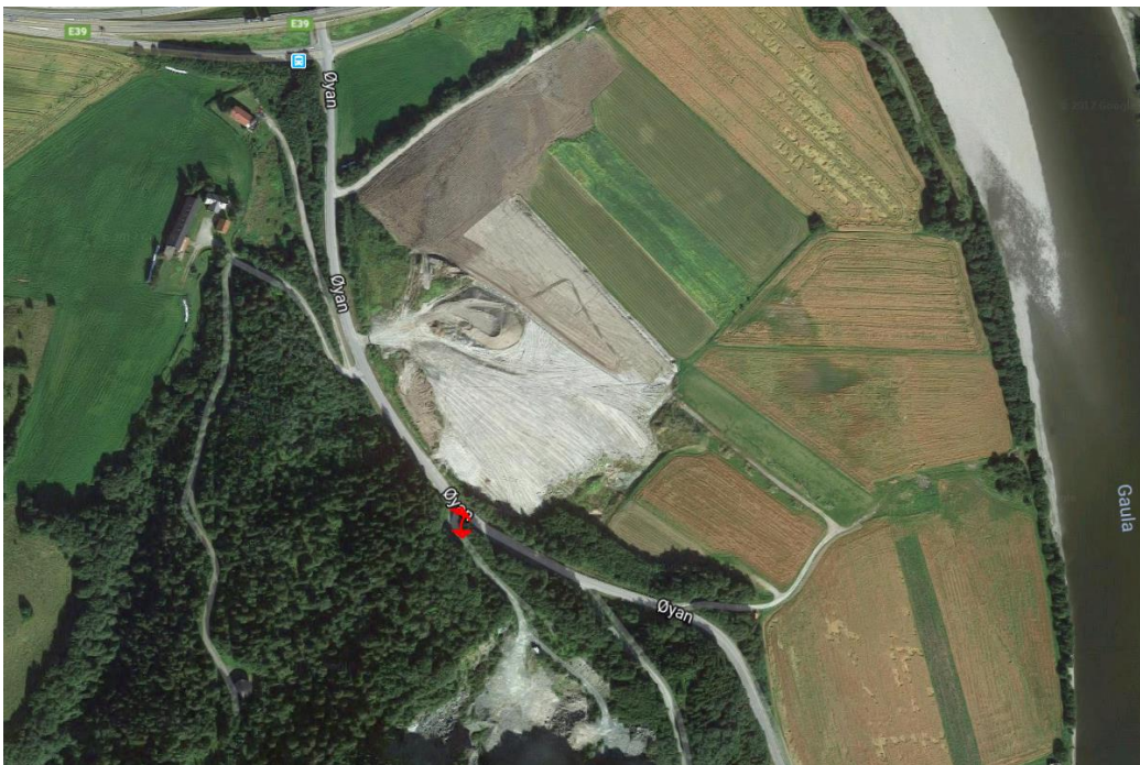
Figur 2: Fv735 Øyan forbi planlagt adkomst til deponiet
