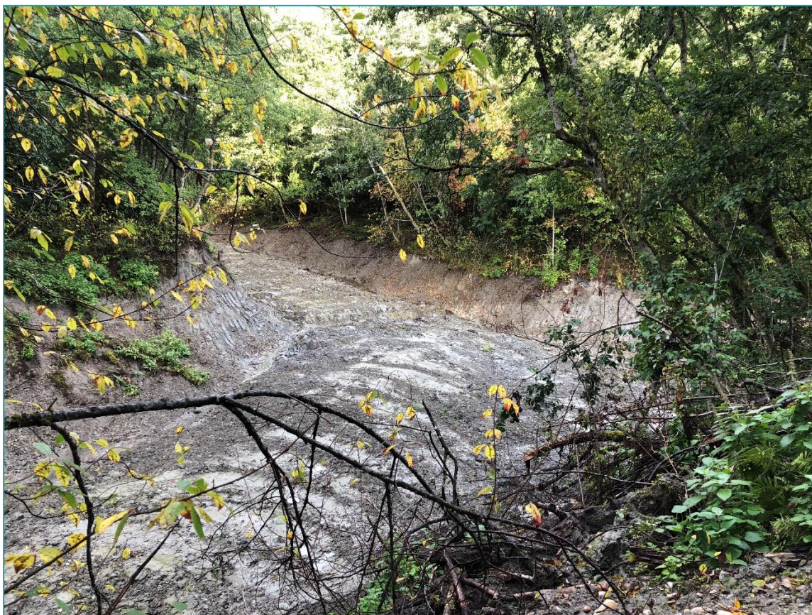
Figur 3: Eksisterende åpen grøft i området hvor grøfta går innpå Varmbobekken.
