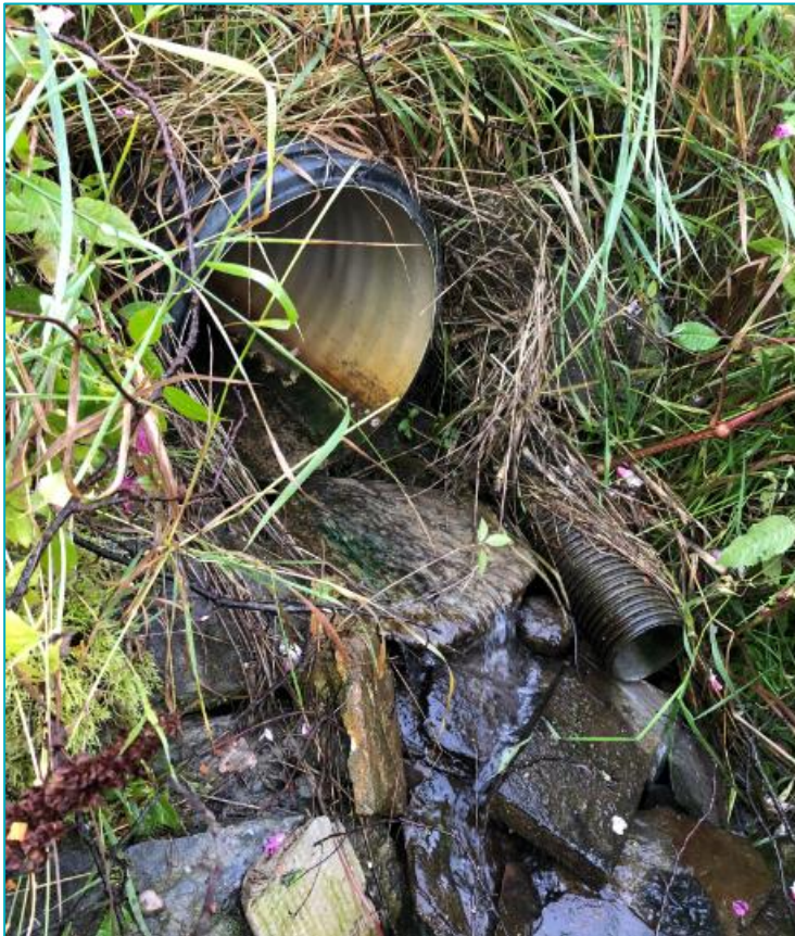
Figur 2: Utløpet til eksisterende kommunal overvannsledning ved skjæringstoppen av ravinen.
