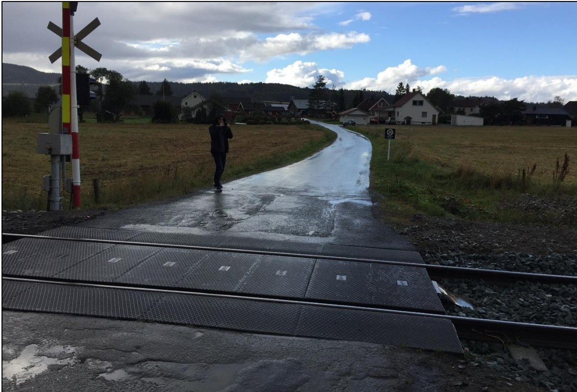
Figur 5: Jernbanekrysningen i Teiavegen (bilde: Sweco).
