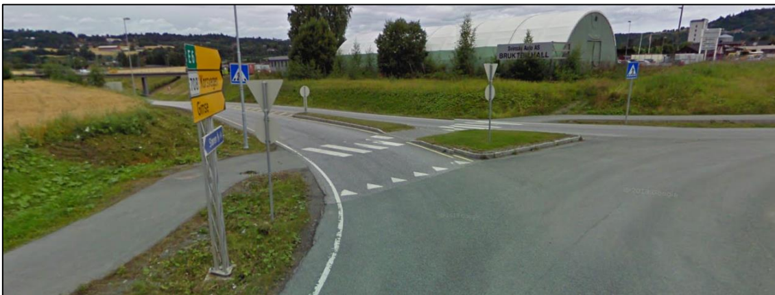
Figur 11: Krysningspunkt 1) er i Hølundvegen. Bildet er tatt i 2010 og kan derfor avvike fra dagens situasjon (bilde: kart.finn.no).
