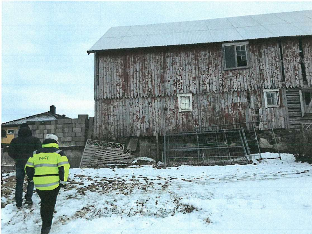
Bilde 20. Eksisterende gammel gård som skal rives ned.
