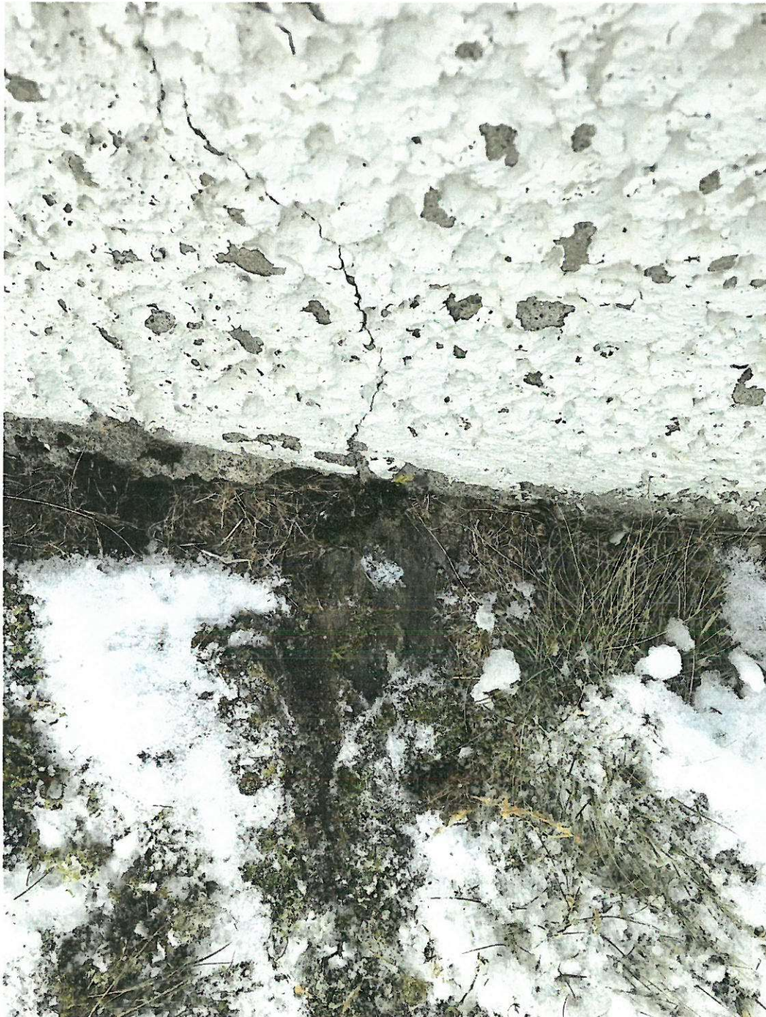
Bilde 18: Berg i dagen under fundament av eksisterende gård.
