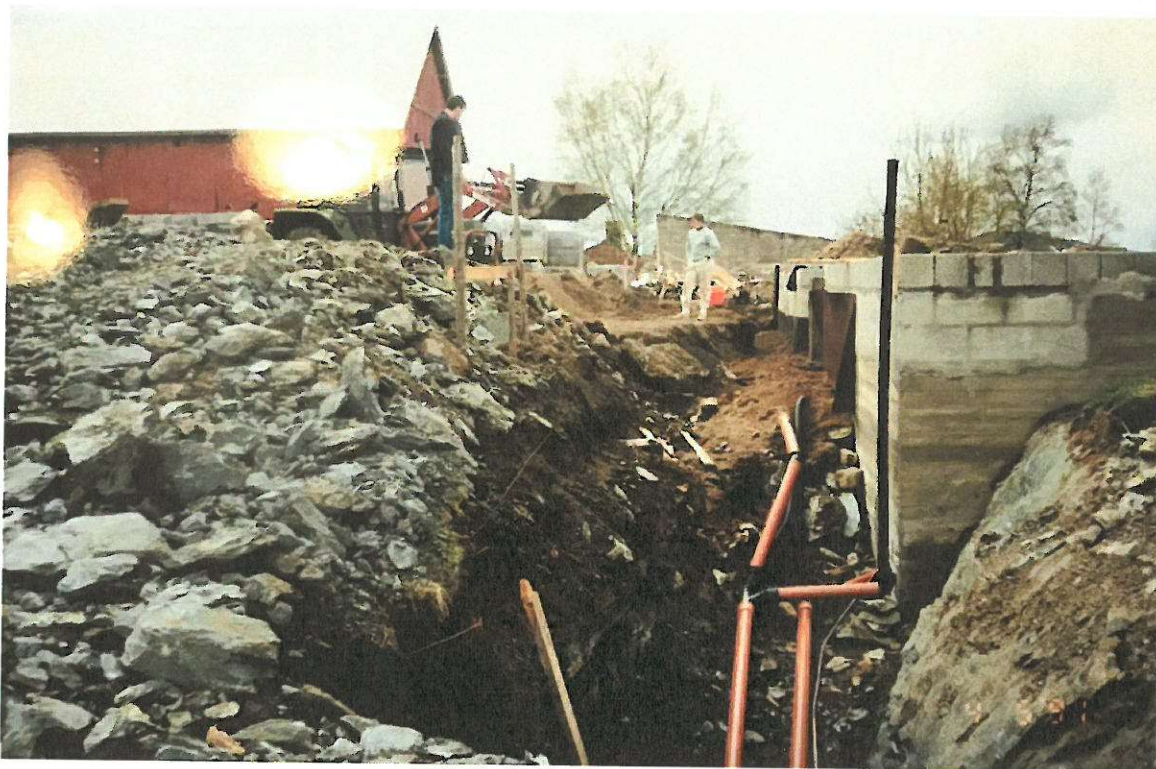
Bilde 3. Utgravd grop for fundament i tomte for eksisterende bolig (Asle Rundberg)
