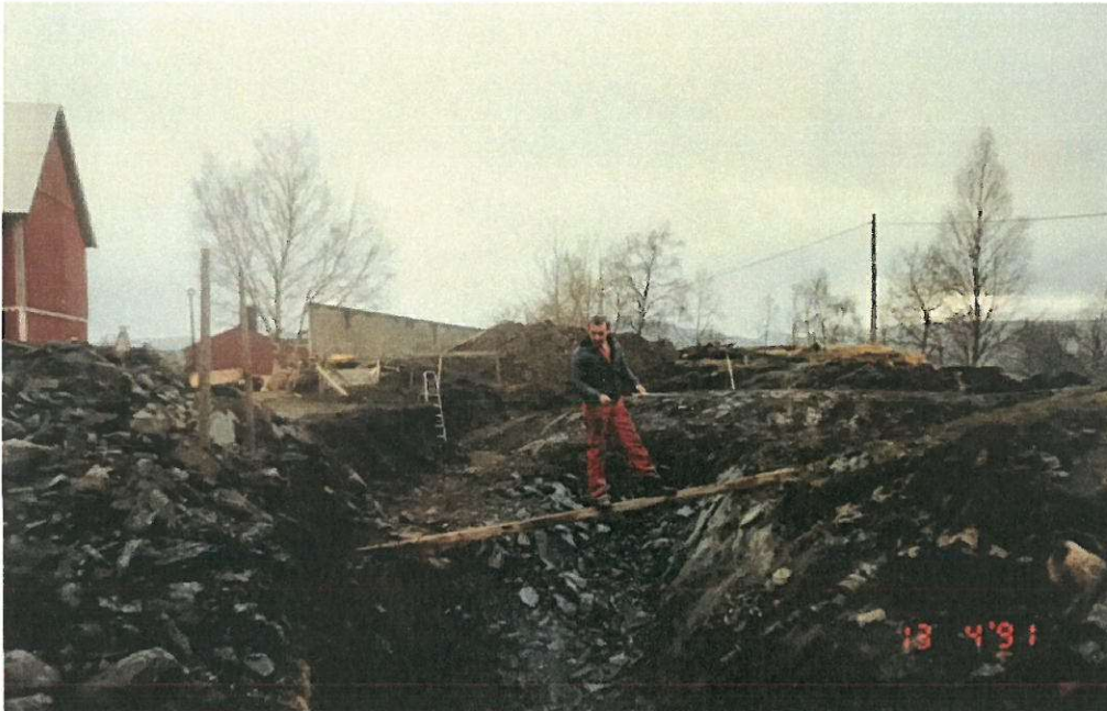
Bilde 2. Utgravd grop på tomte for eksisterende bolig som viser berg under terreng (Asle Rundberg)
