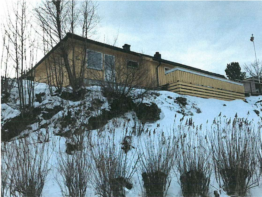
Bilde 8. Bratt bergkant på ca. 3-4 m høyde på nordvest side.
