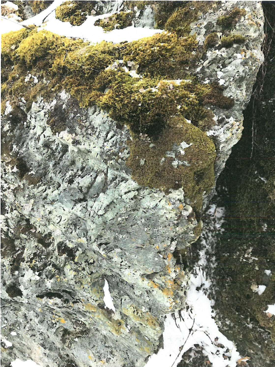
Bilde 16. Nærbilde av bergkant og sprekke.
