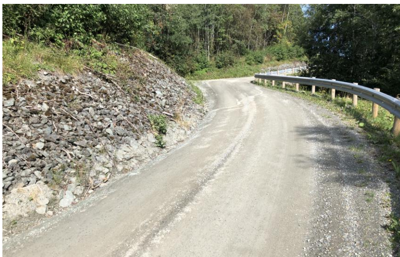
Bilde 11. Plastring veiskjæring med kult
