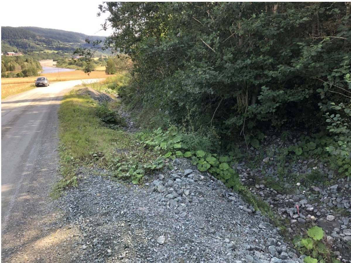
Bilde 3. Åpen bekk langs sørsiden av Kregnesveien
