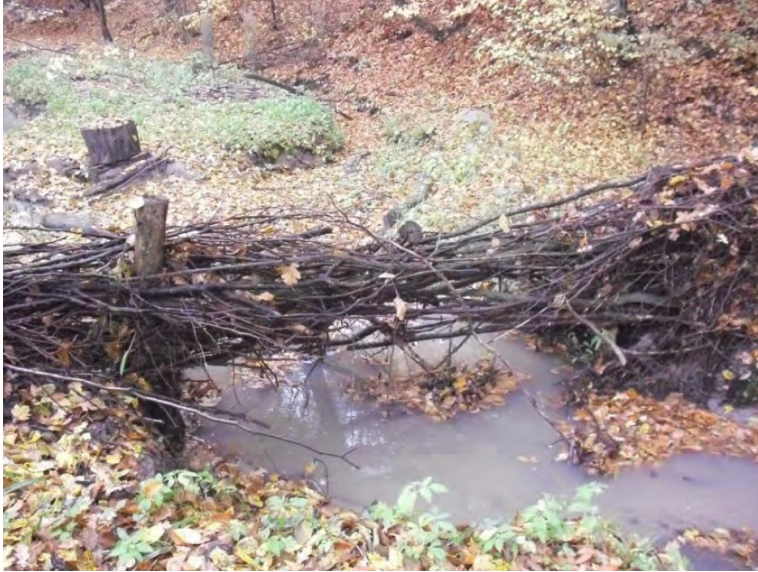
Fra NIFS rapport 28/2014 «Kvistdammer i Slovakia». Eksempel på dårlig bygd kvistdemning
