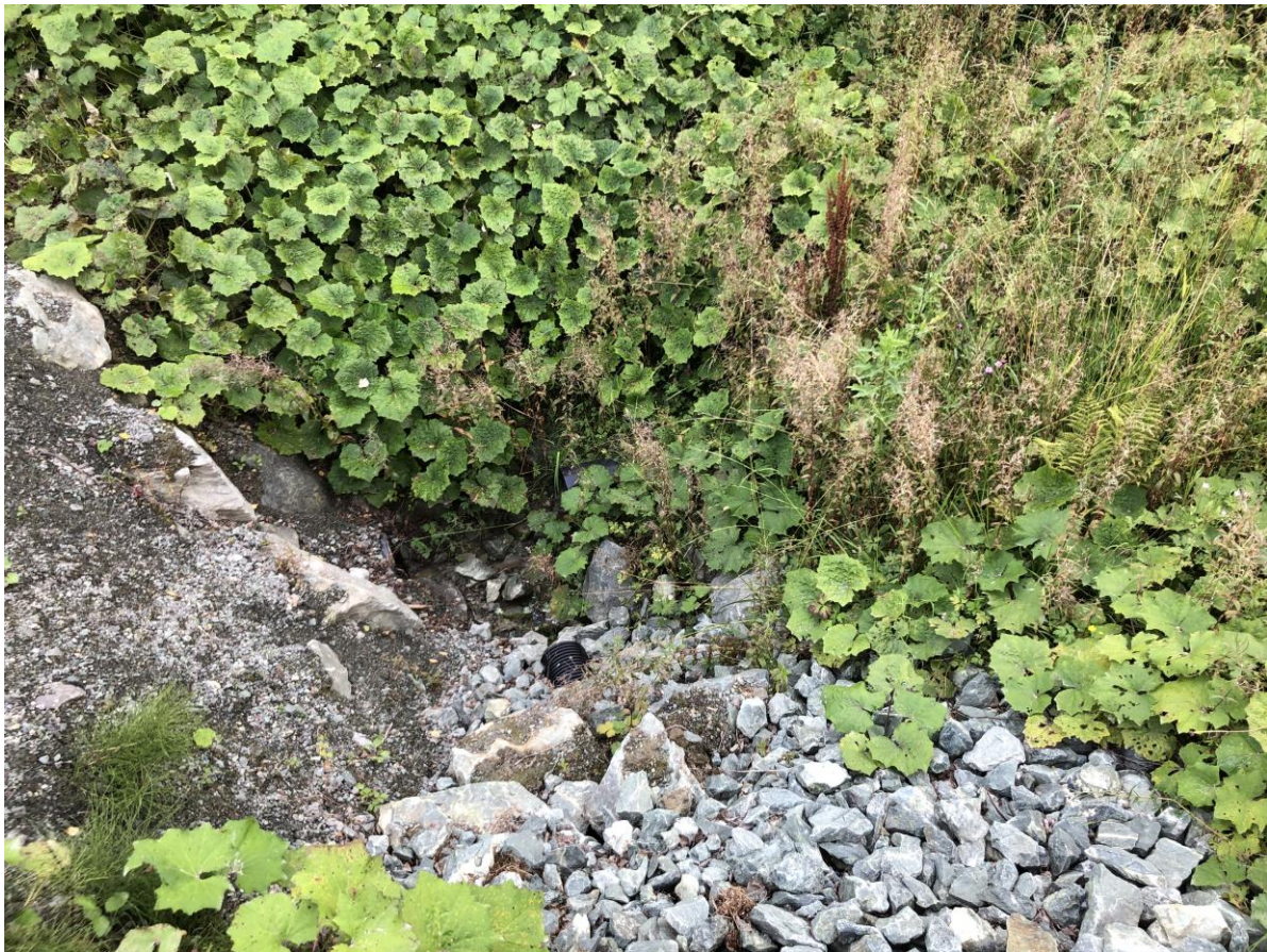
Bilde 17. Åpen grop for utløp tilløpsledninger og inntak stikkrenne Ø300 gjennom Kregnesveien
