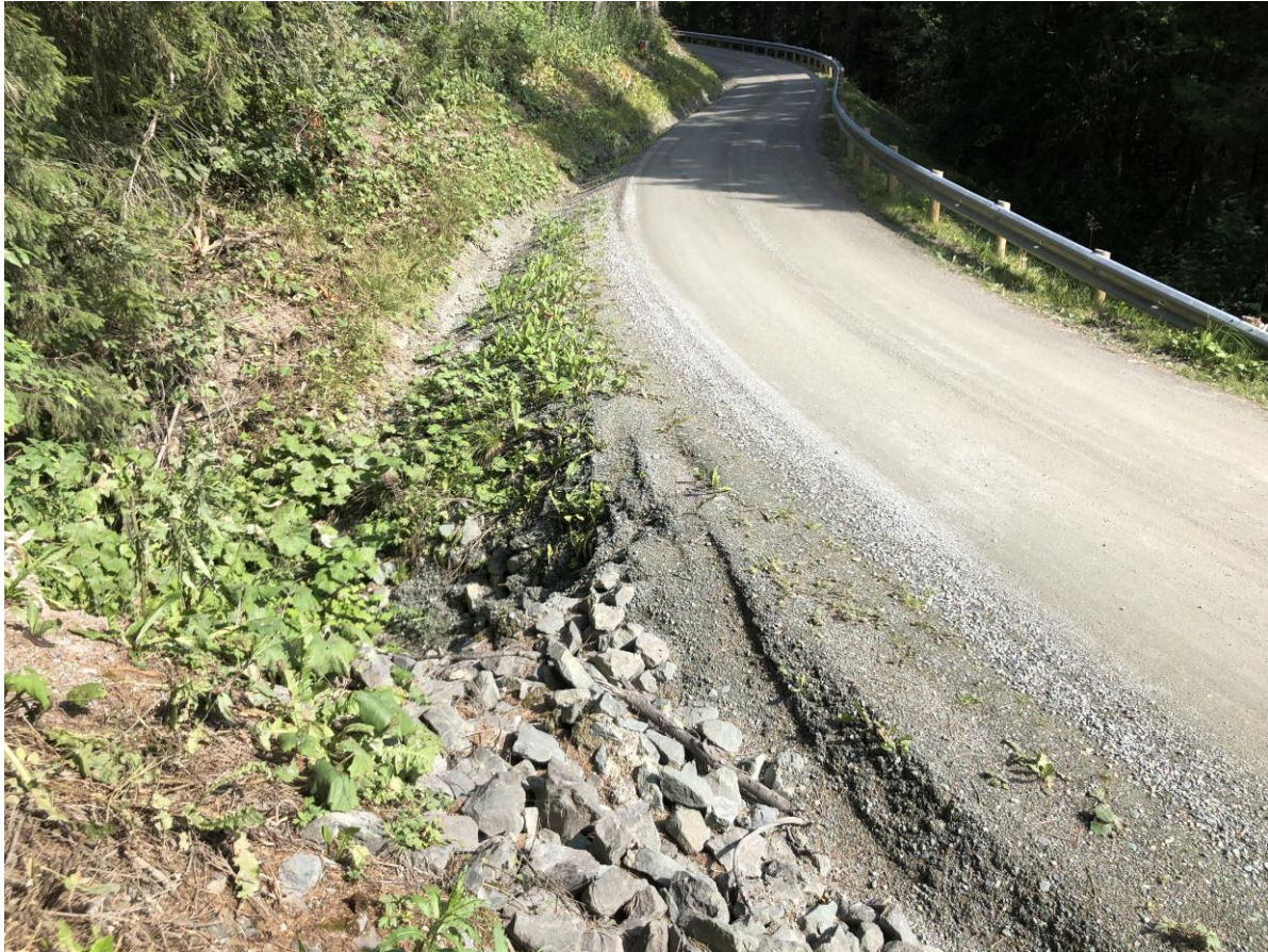
Bilde 8. Plastring veigrøft med kult
