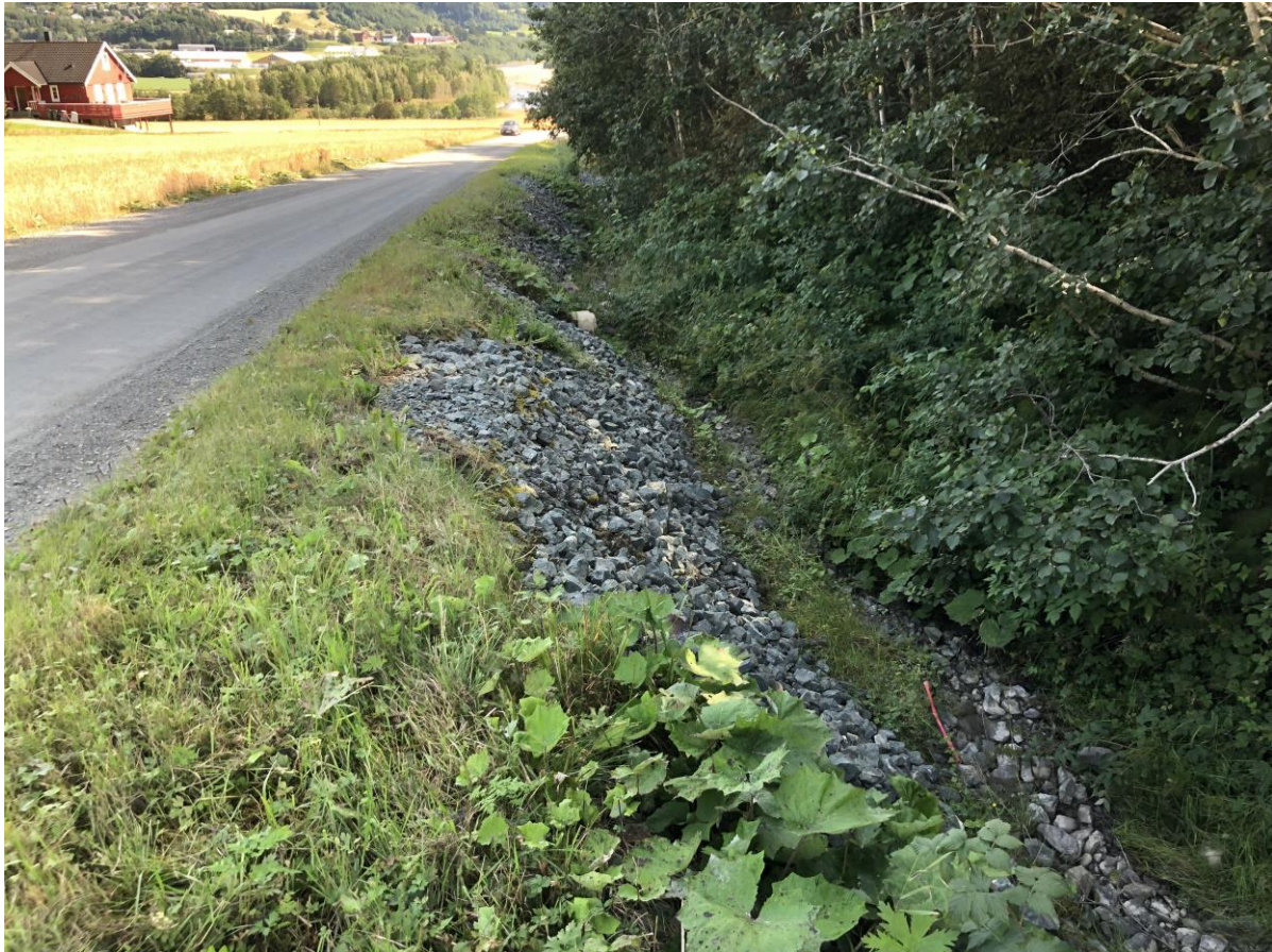
Bilde 4. Åpen bekk langs sørsiden av Kregnesveien
