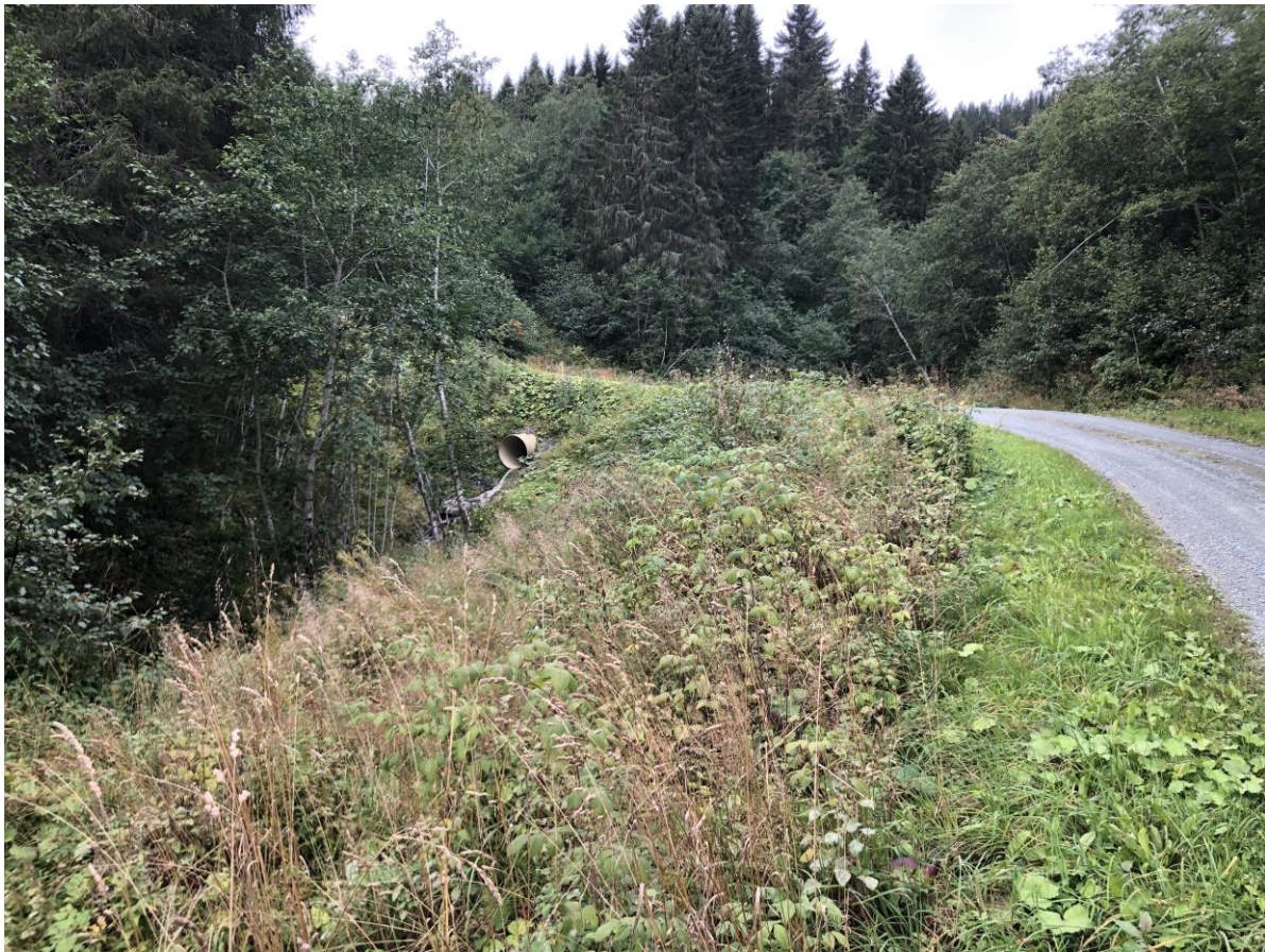
Bilde 19. Kulvert \varnothing 1200 under gårdsveg til ssssss
