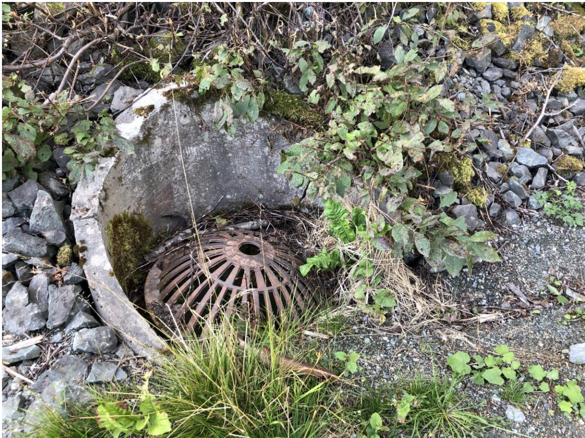
Bide 16. Grunt sandfang ved innløp stikkrenne Ø150 gjennom Kregnesveien
