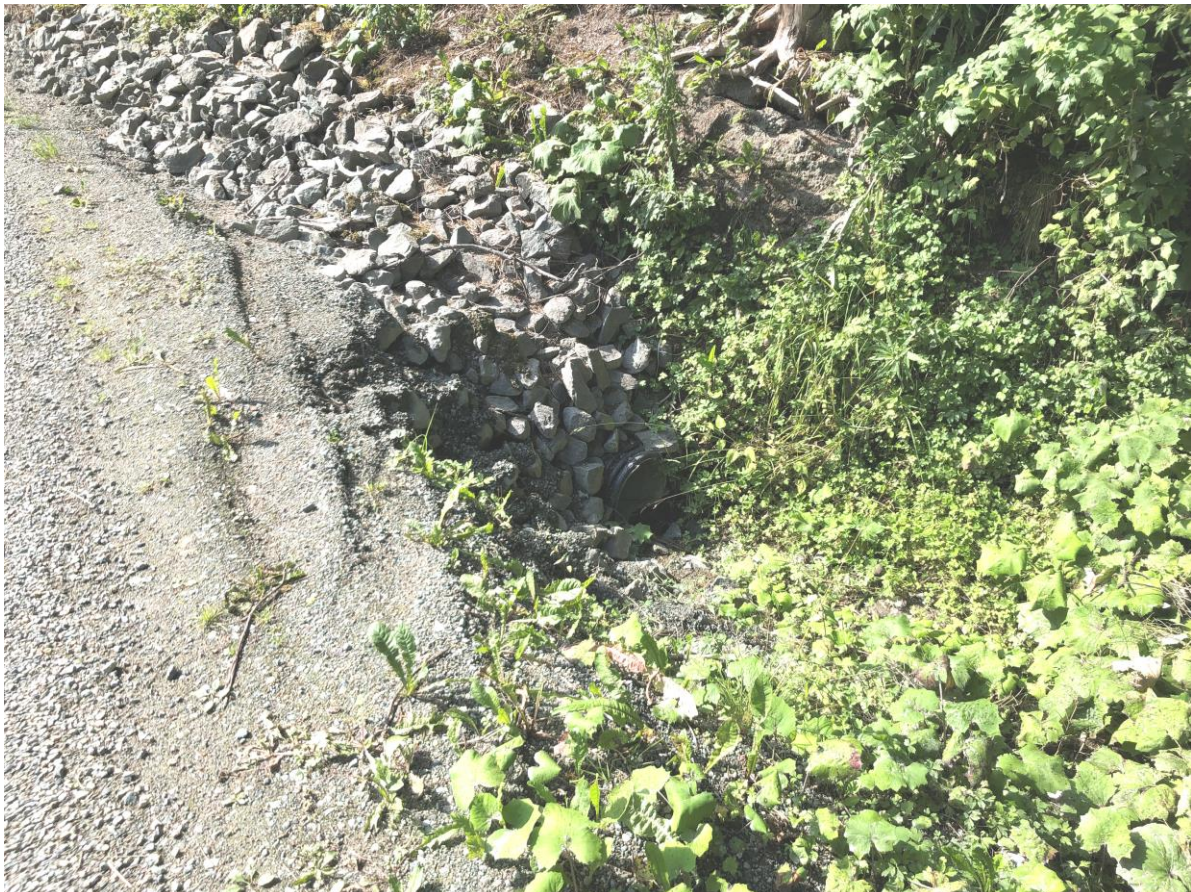
Bilde 9. Inntak stikkrenne Ø400
