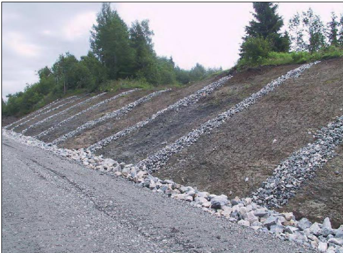
Fra Håndbok N200. Skråningsdren vinkelrett på vegrøfter
