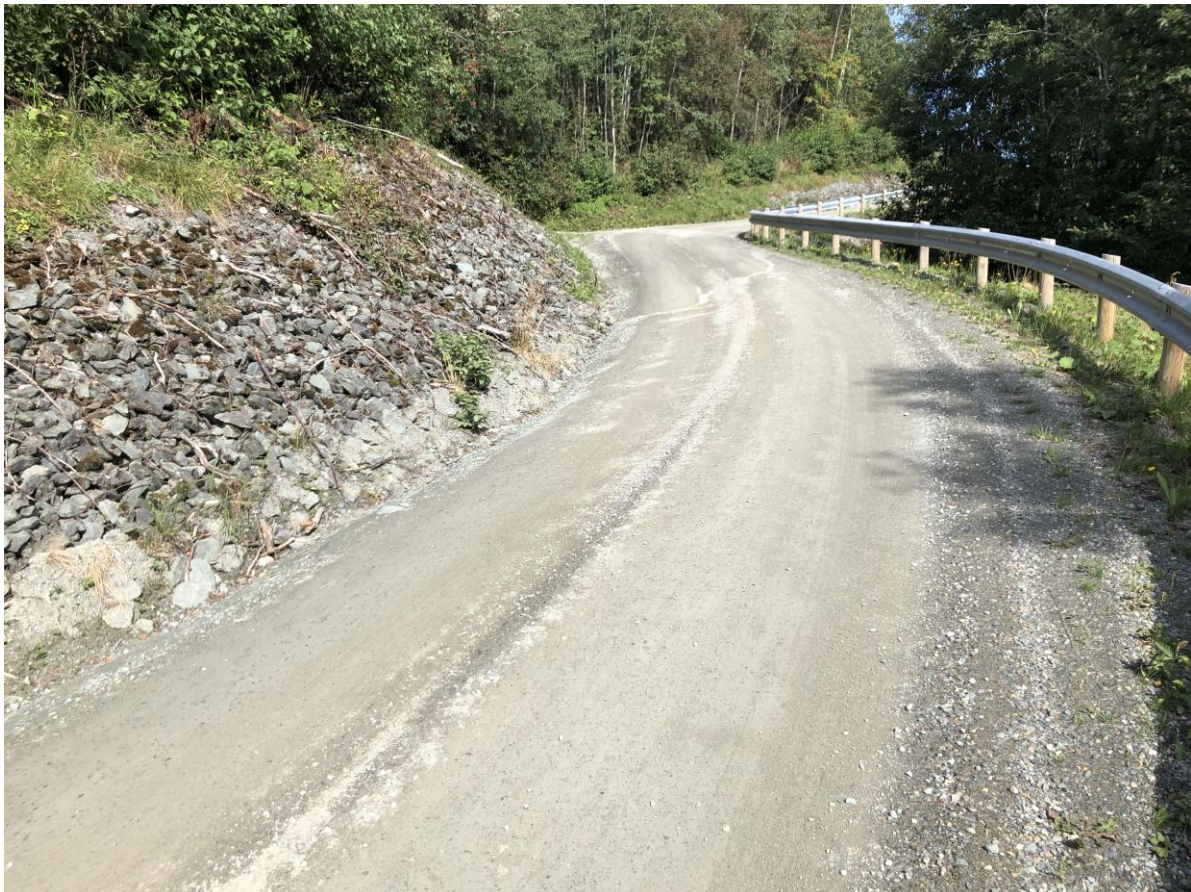
Bilde 11. Plastring veiskjæring med kult 30-300
