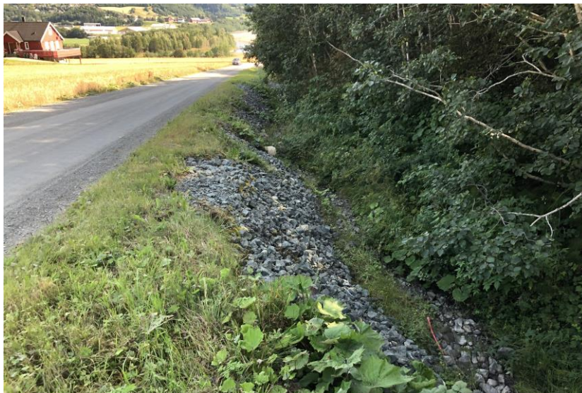
Bilde 4. Åpen bekk langs sørsiden av Kregnesveien
