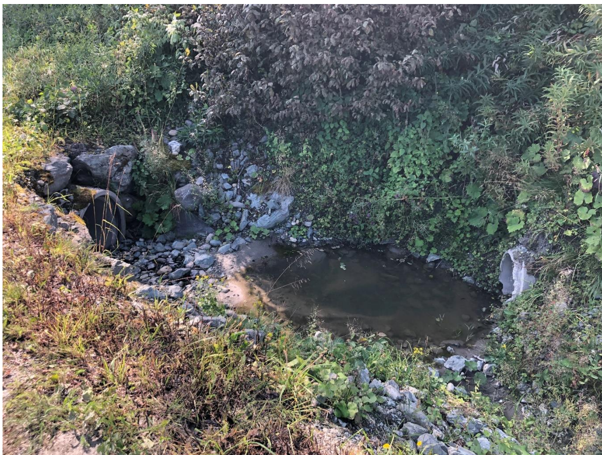
Bilde 2. Åpen slamgrop inn til kulvert Ø800
