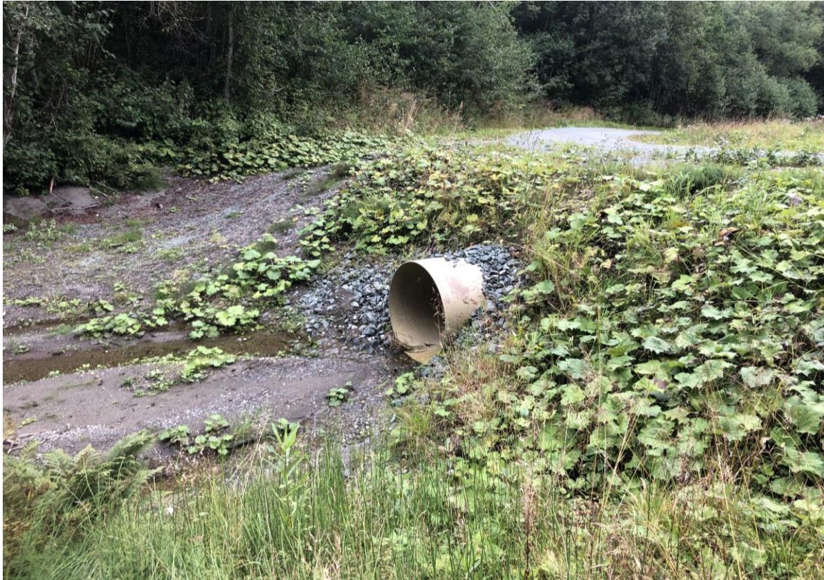
Bilde 21. Inntak kulvert Ø1200
