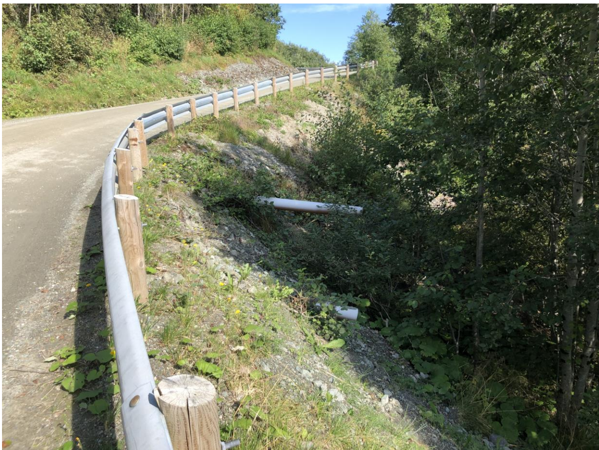
Bilde 13. Stikkrener Ø160 gjennom Kregnesveien
