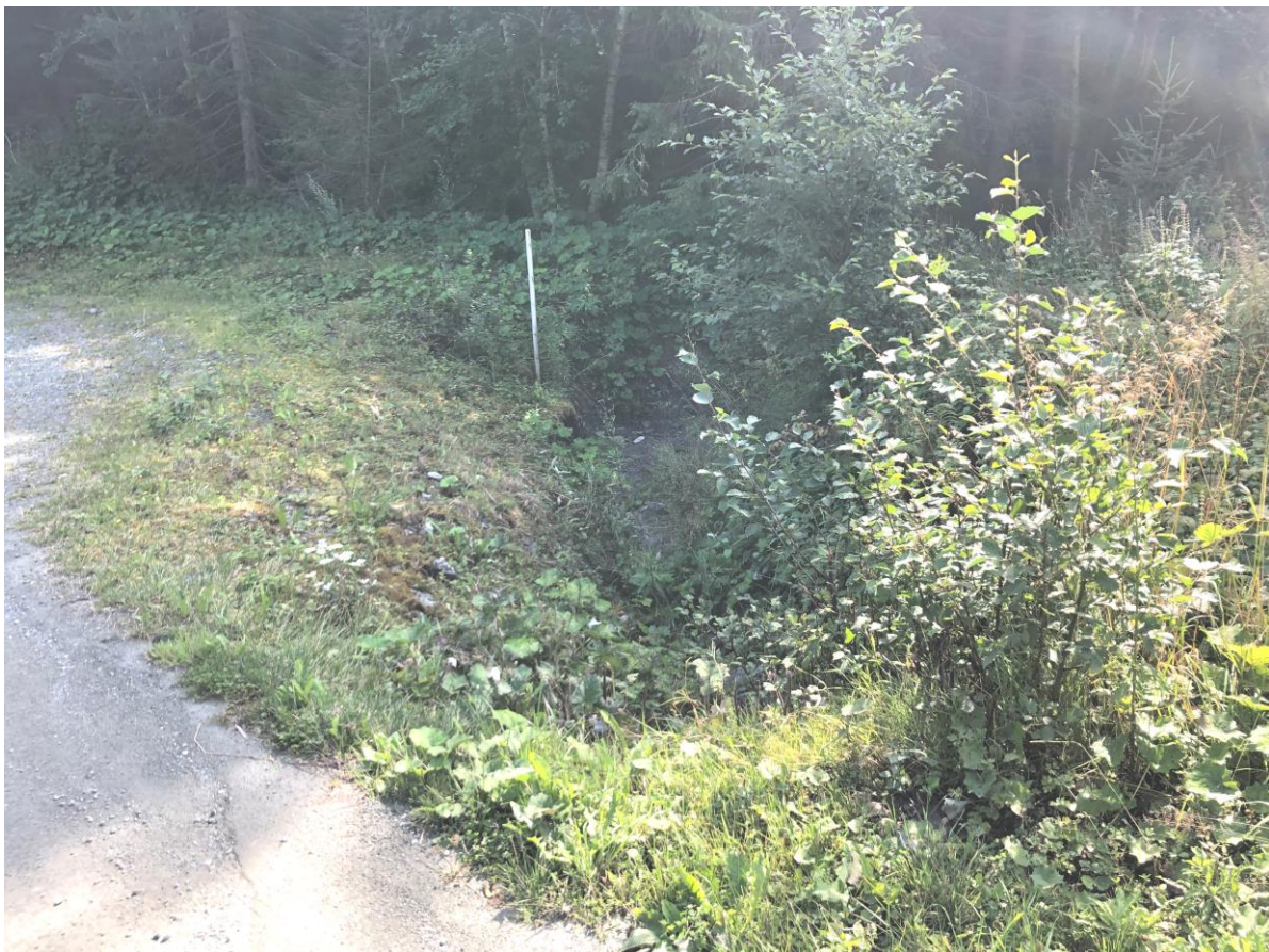
Bilde 7. Åpen bekk oppstrøms kulvert Ø600 langs sørsiden av Kregnesveien
