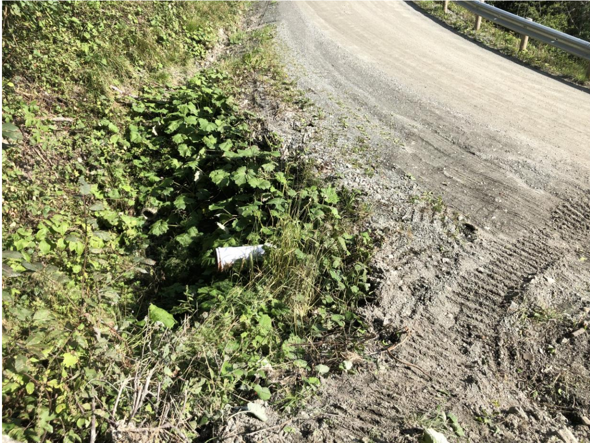
Bilde 12. Innløp stikkrenne Ø160 gjennom Kregnesveien
