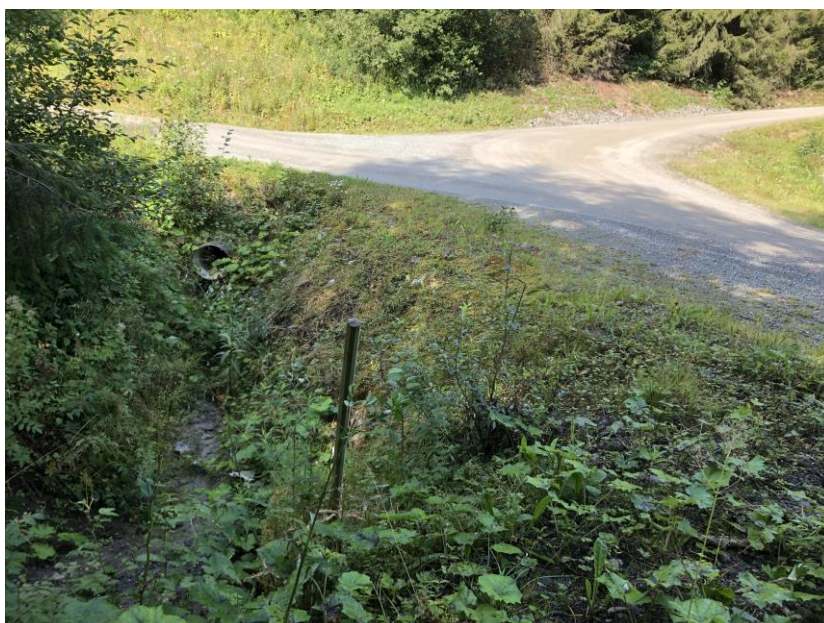
Bilde 6. Åpen bekk oppstrøms kulvert Ø600 langs sørsiden av Kregnesveien
