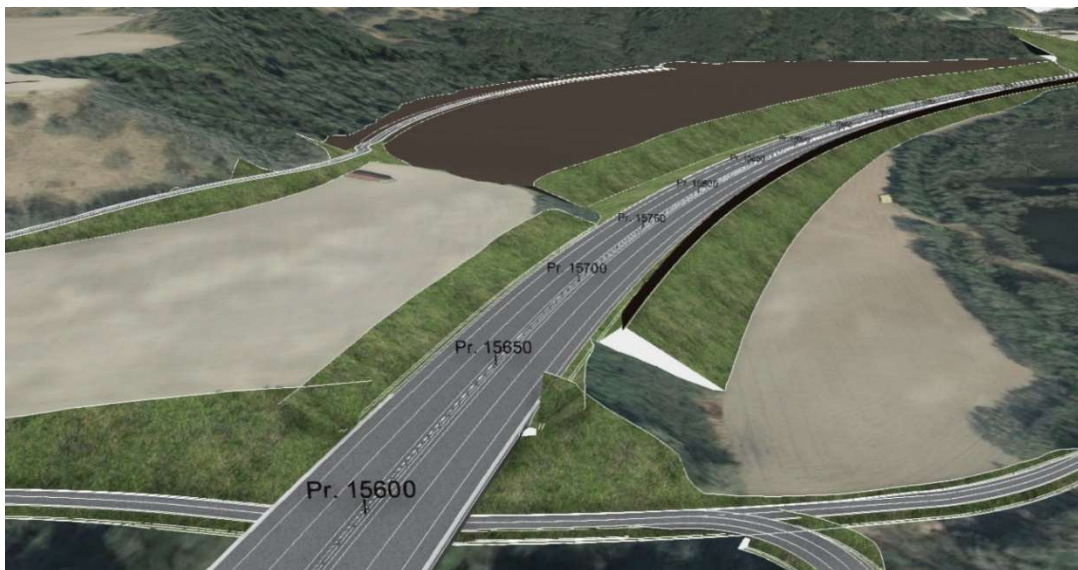
Figur 4-15 Det planlegges en større oppfylling langs E6 ved Kåsa som bidrar til en forbedring av områdets stabilitet. Etter anleggsperioden vil dette bli et større jordbruksareal enn det man har i dag i samme område (Kilde: Norconsult).
