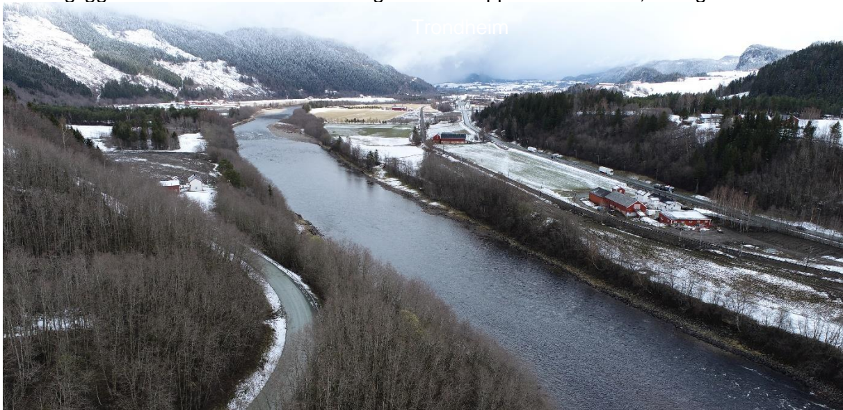
Figur 3-9 Dalrommet sett fra Sandbrauta mot nord (Foto: Norconsult).
