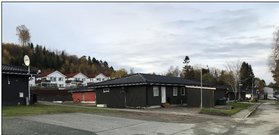
Figur 1010 Bilde av Brekktrøa 39, i dag ombygd til en tremannsbolig. Bildet er tatt i oktober 2021.
