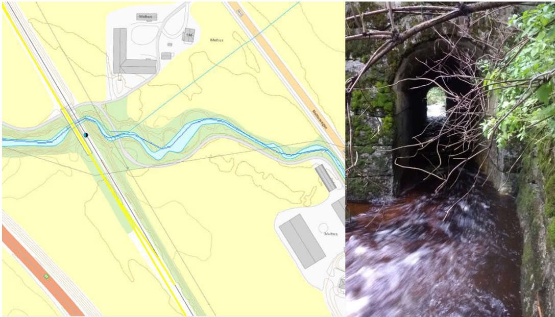
Figur 24 Jernbanekulverten for Lodbekken. Kartutsnitt til venstre og bilde av til høyre. (NVE, 2022)
