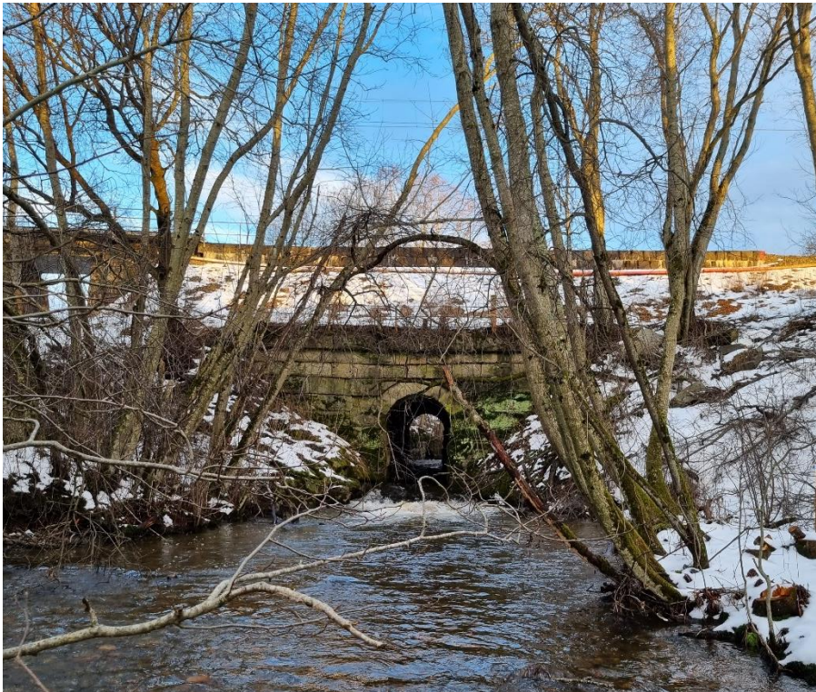
Figur 8: Bildet er tatt nedstrøms eksisterende kulvert under jernbanen. I dette området renner bekken i et nokså bredt løp, og substratet består av stein og grus. Bekkekantene består av en leirravine med godt utviklet kantvegetasjon. Vegkulverten kan skiftes øverst til benstre i bildet bak trærne. Foto: Rambøll, 2022.
